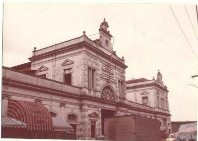
FOTO 11- Vista da fachada do prédio principal.
