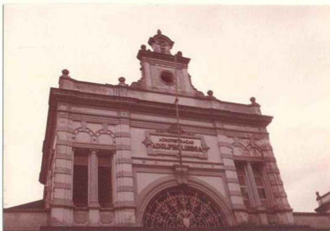
FOTO 8- Detalhe da fachada principal do Mercado. F105962
