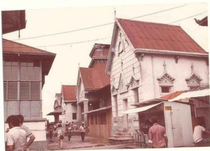
FOTO 16- Pavilhão sanitário do Mercado. Fachada voltada p/o Rio Negro.
