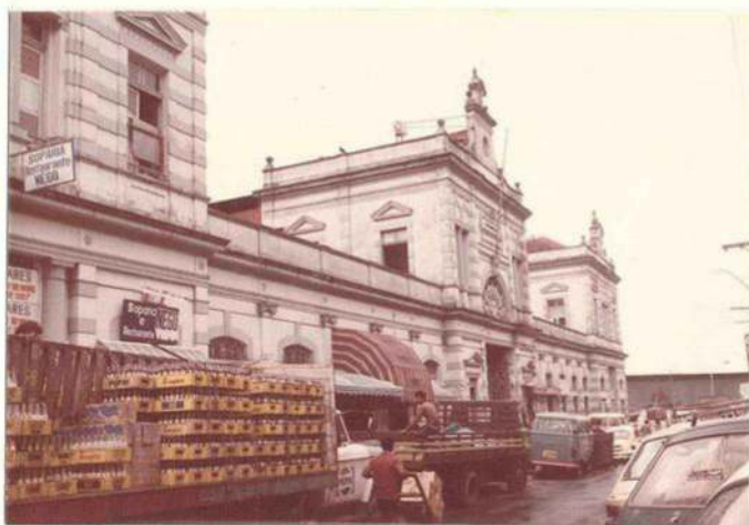
FOTO 10- Vista da fachada principal do Mercado
