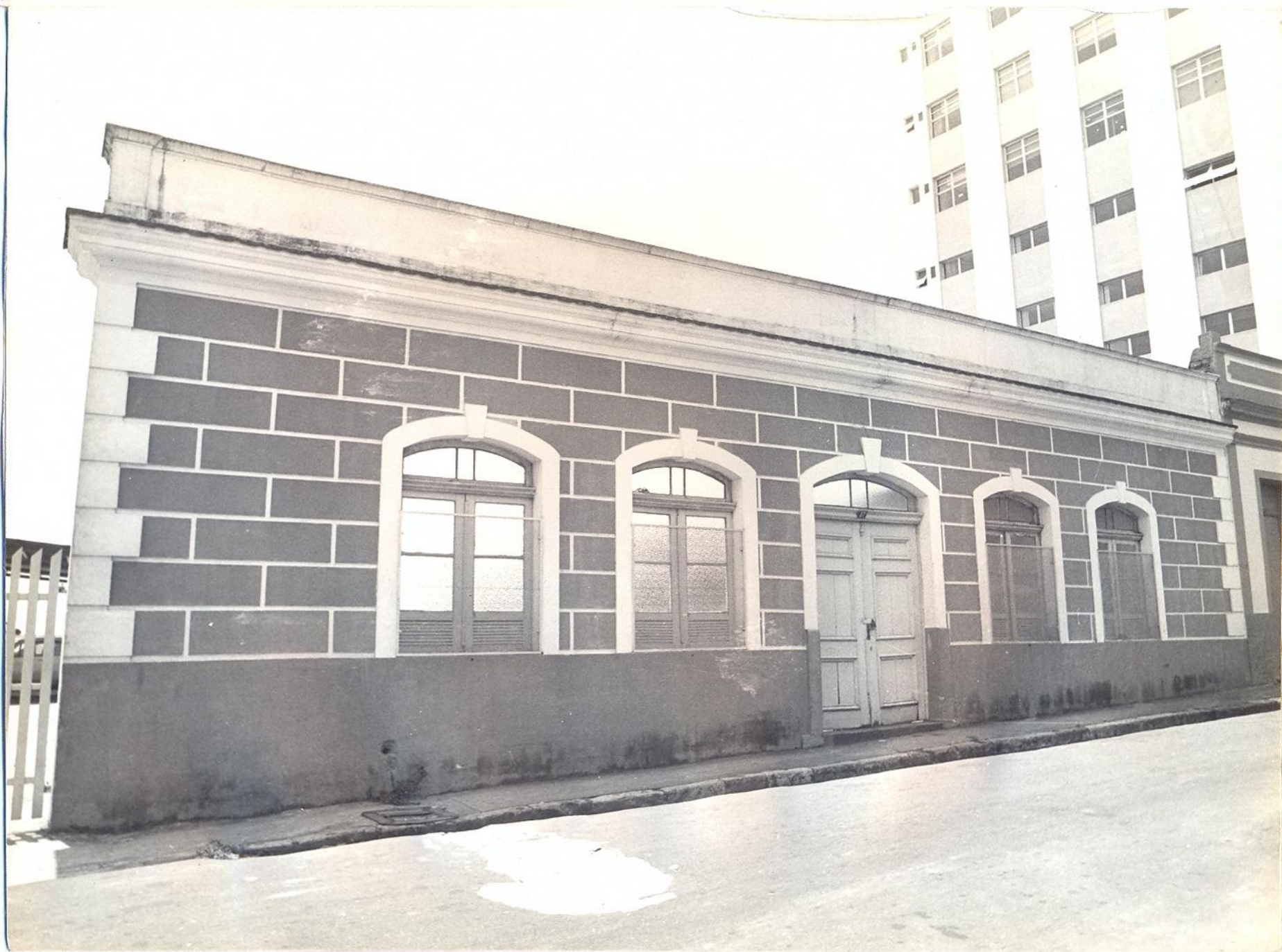
FACHADA CONTRUÍDA PARA ENCOSTAR O ARMAZÉM DO ALMOXARIFADO AO PRÉDIO DO ESCRITÓRIO CENTRAL DA M.H.L. (ATUAL)
