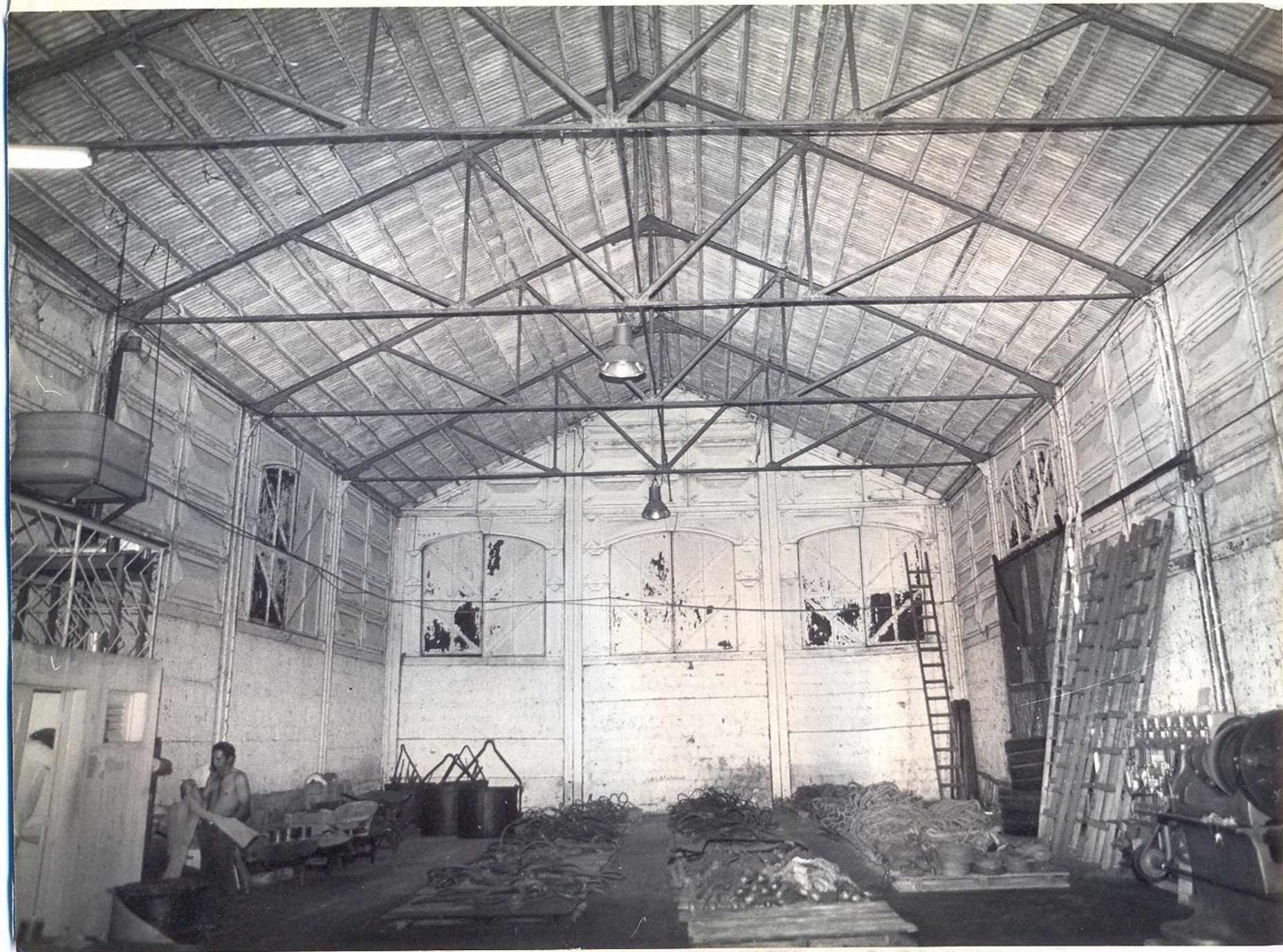
TRAPICHE 15 DE NOVIEMBRE (PARTE INTERNA - ATUAL)
