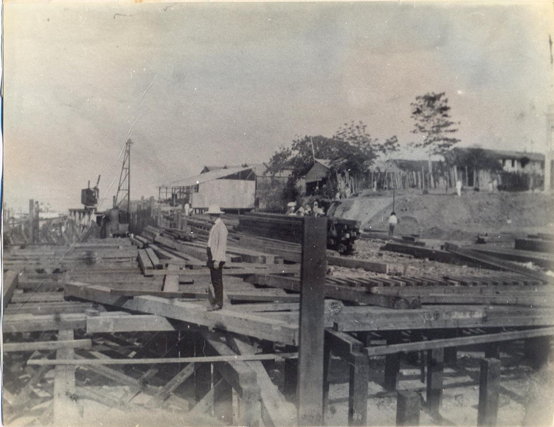
ASPECTO DA CONSTRUÇÃO DO PORTO DE MANAUS (1903)
