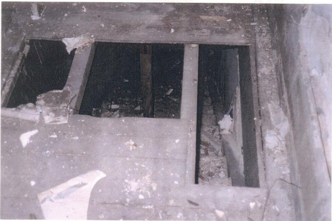
PISO (ESCADA ENCLAUSURADA)
