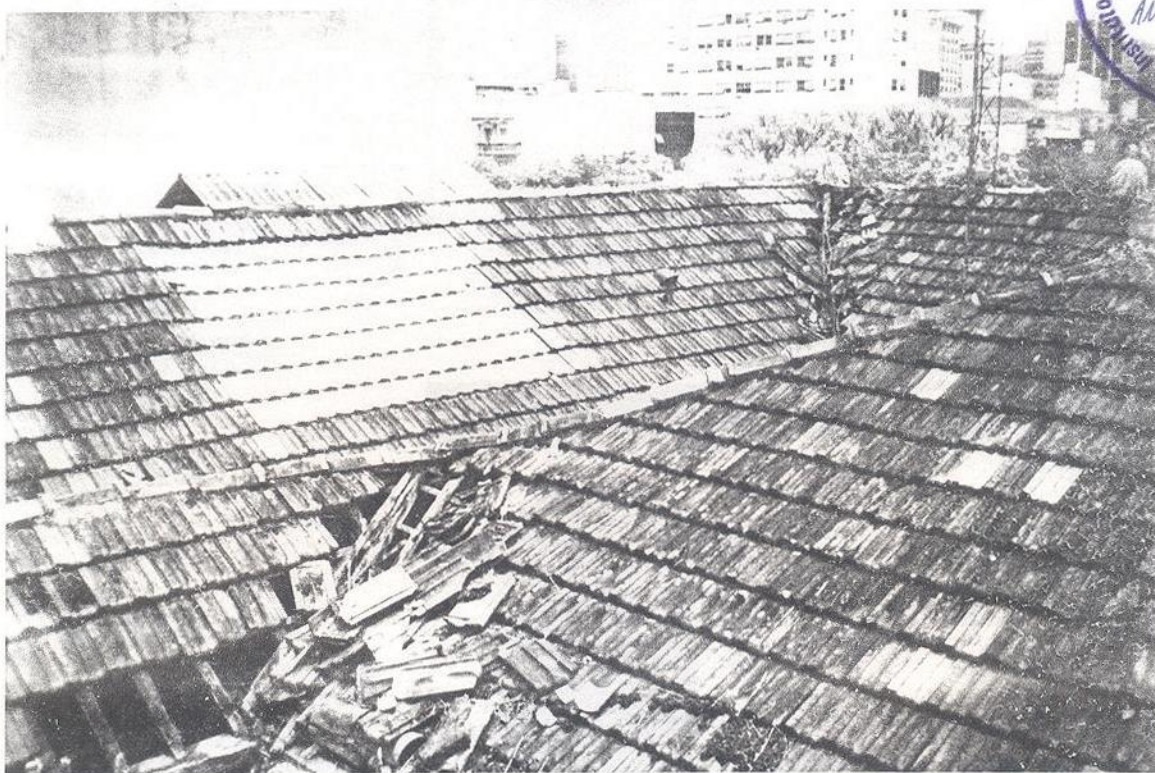
TELHAS DE VIDRO SOBRE O VITRAL
