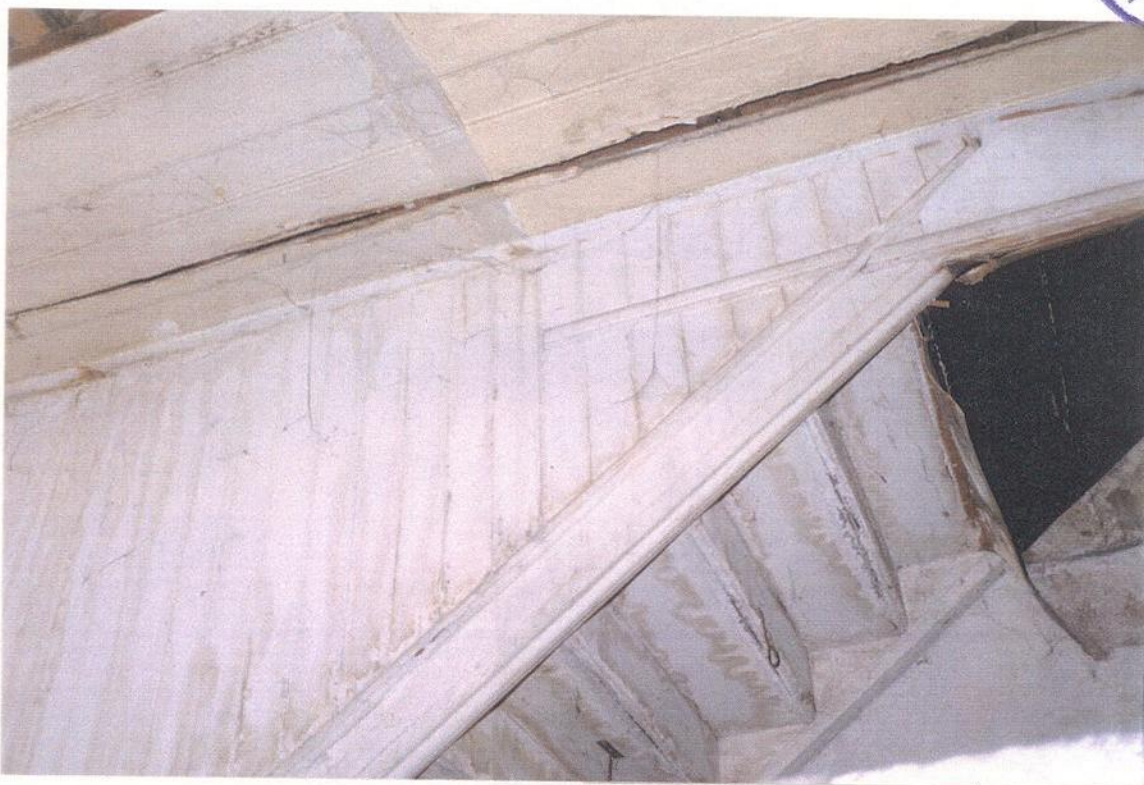
TETO (ESCADA ENCLAUSURADA)
