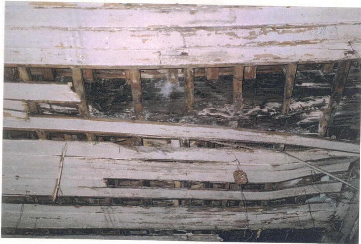
TETO (VIGA SECCIONADA)
