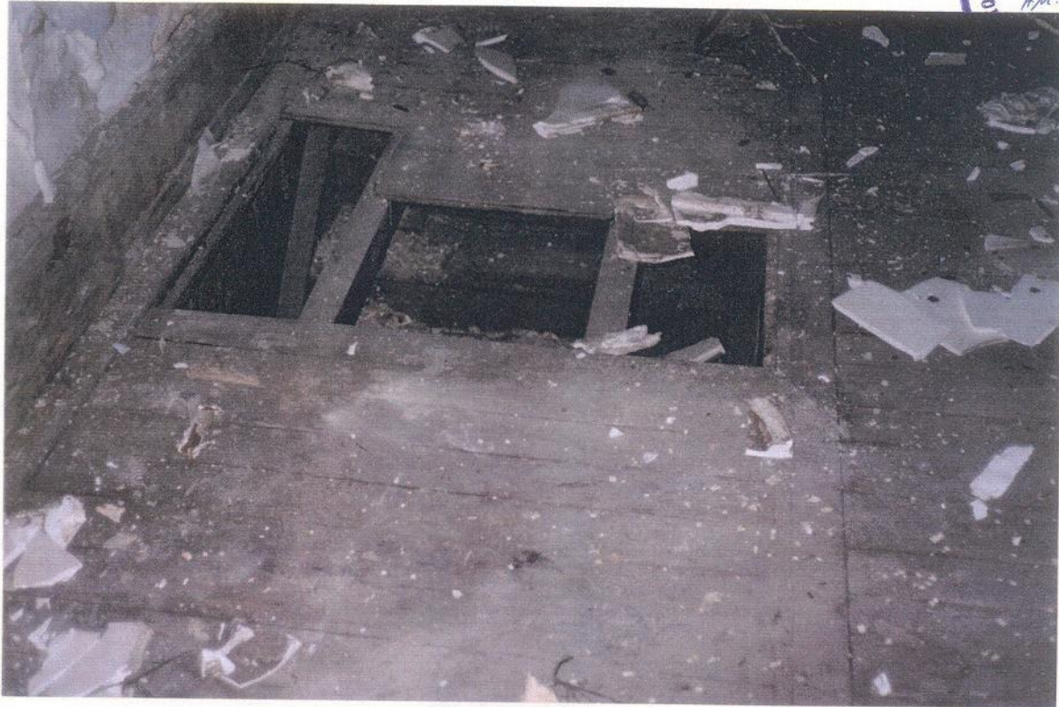
PISO (ESCADA ENCLAUSURADA)
