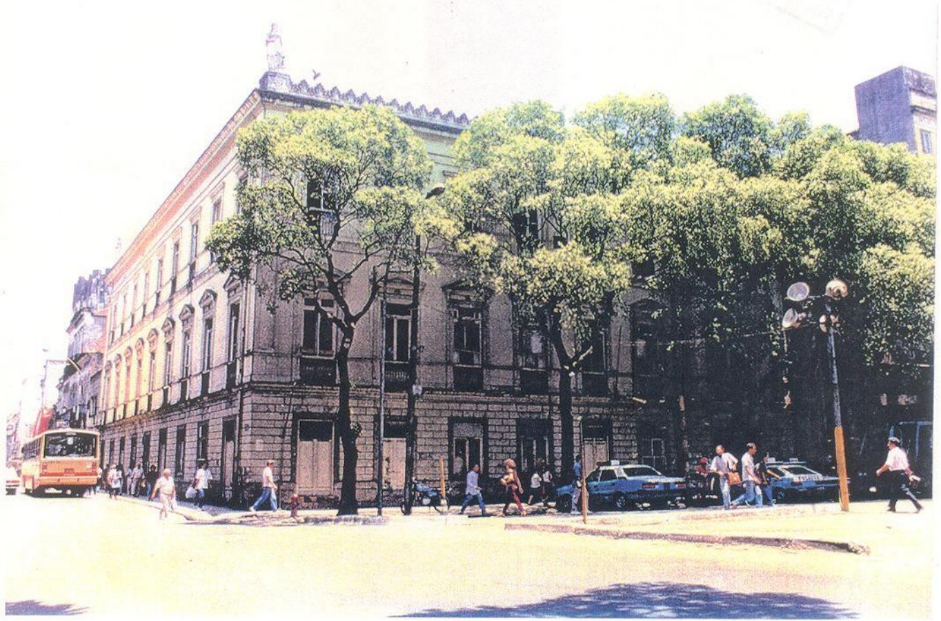
ANTIGO SOLAR DO BARÃO DO RIO SECO
