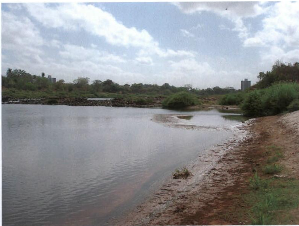
Foto 9. Margem esquerda sem ocorrências.
