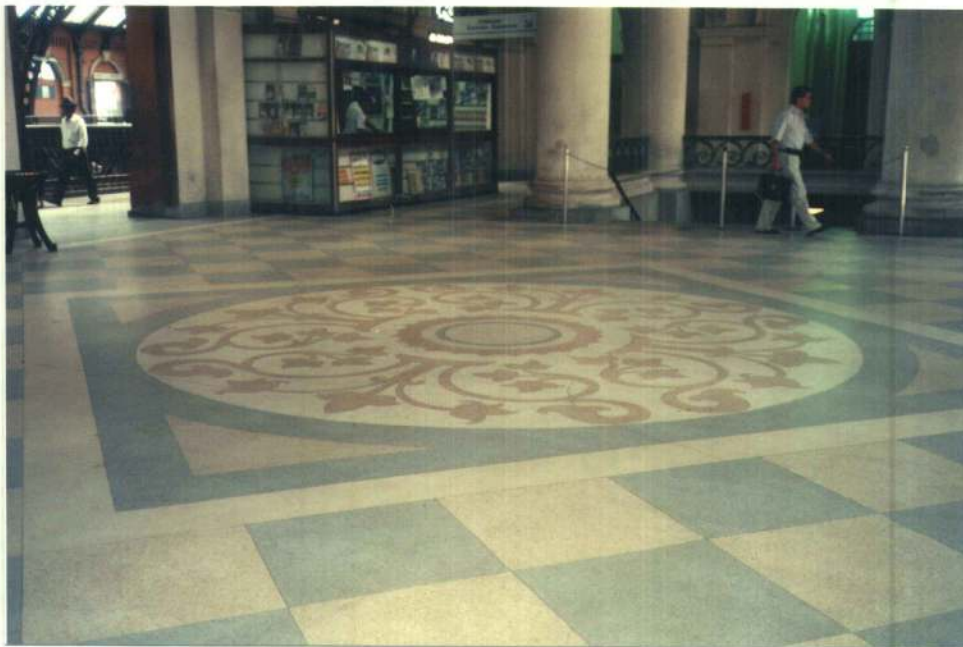
PISO DO SAGUÃO PRINCIPAL (ENTRADA PELA TRAVEZ DA LUZ)
