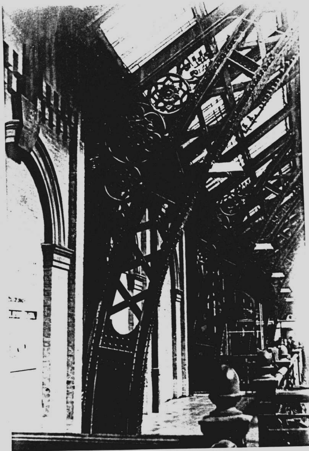
Detalhe da estrutura metálica que suporta a cobertura da gare.
