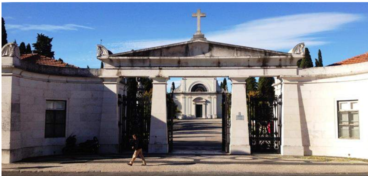
Img.72: Pórtico de entrada do cemitério dos Prazeres, Lisboa – Portugal (Foto: Paula Rodrigues, 2013)
