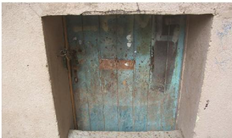
1. Fachada Norte (fundos)
