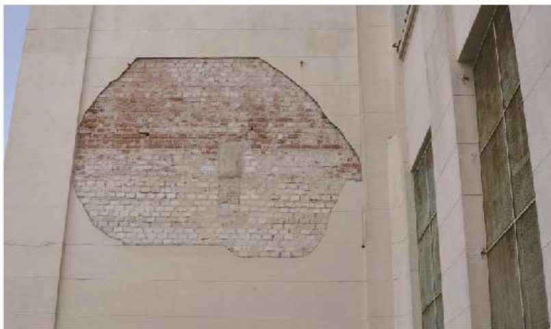
2. Fachada Norte (fundos)
