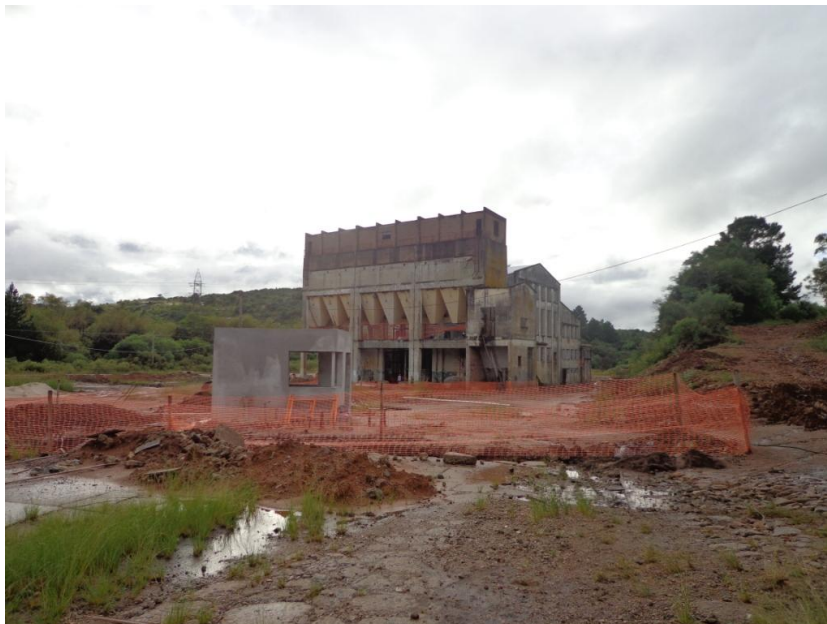
Figura 17: Limpeza Usina Velha.
