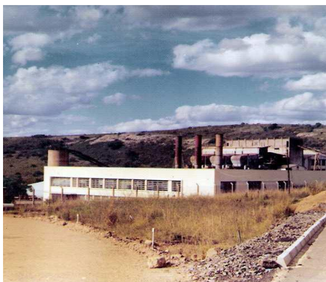
Figura 15: Conjunto arquitetônico da Usina Candiota I.
