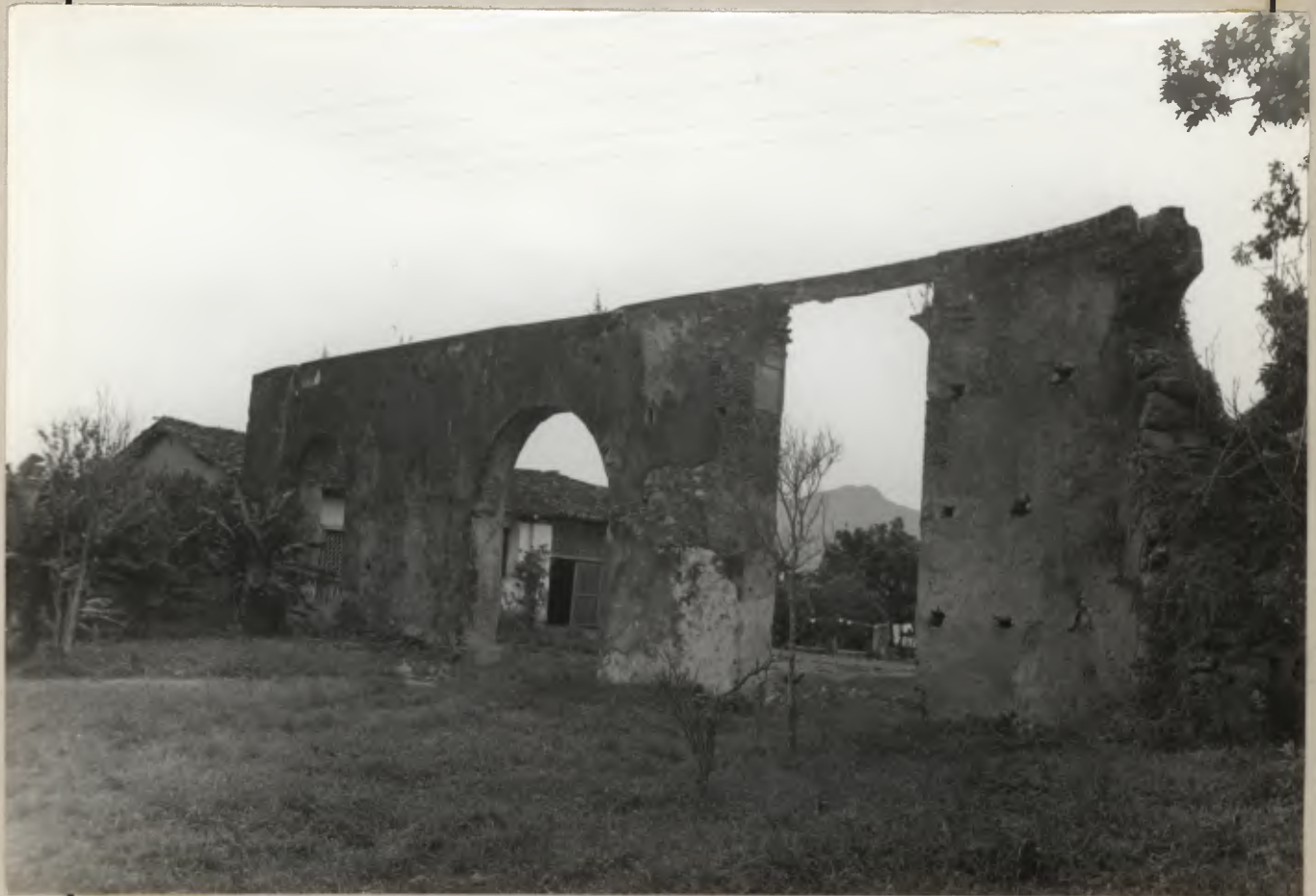
1466 (IPHAN) - Ruínas do aqueduto.
