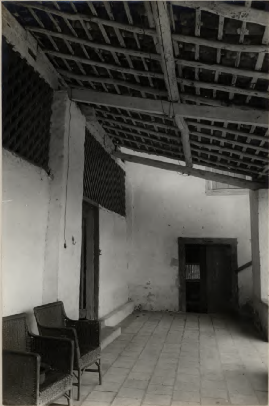
1462 (IPHAN) - Varanda no pavimento térreo.
