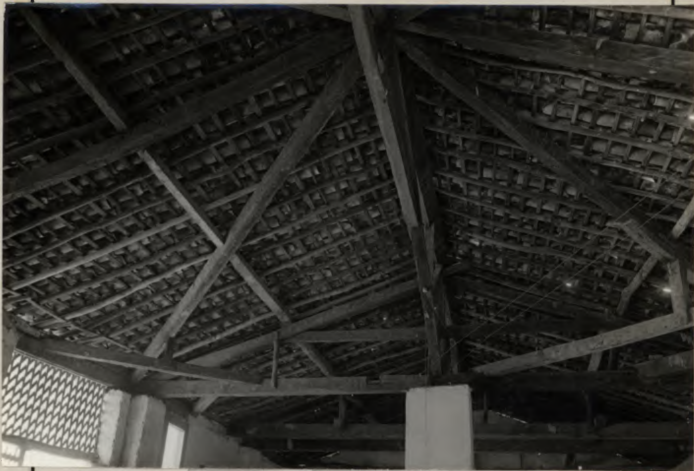
1463 (IPHAN) - Casa-grande/ detalhe da armadura do telhado.
