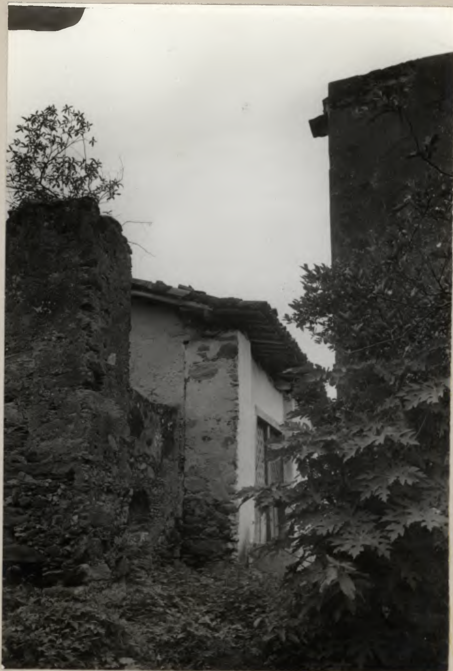
1467 (IPHAN) - Ruínas do aqueduto.
