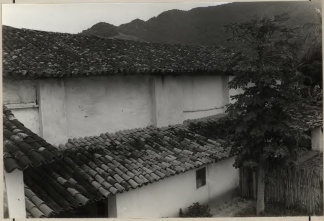
1458 (IPHAN) - Casa-grande: detalhe lateral.
