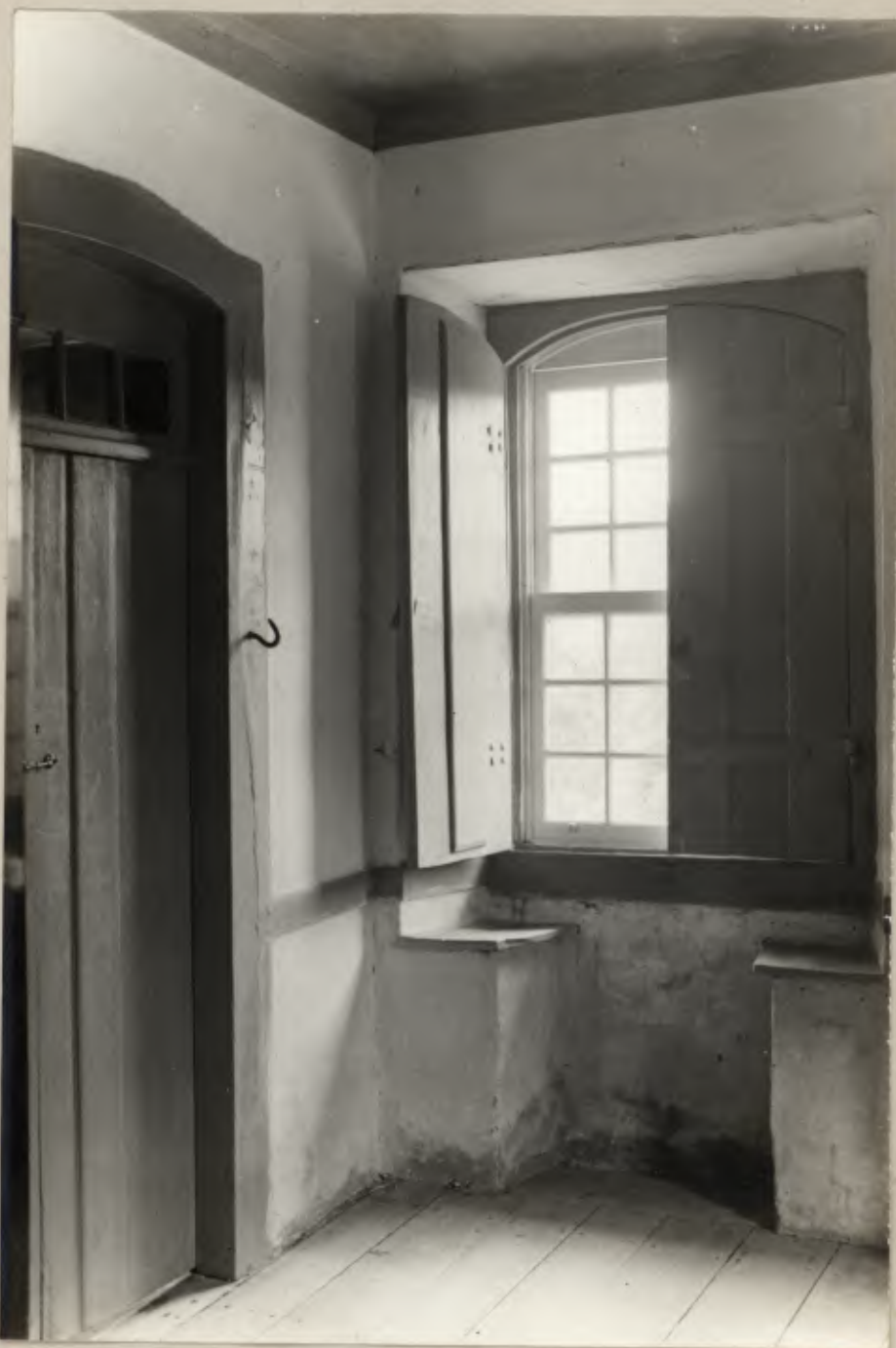
1464 (IPHAN) - Janela da casa-grande.
