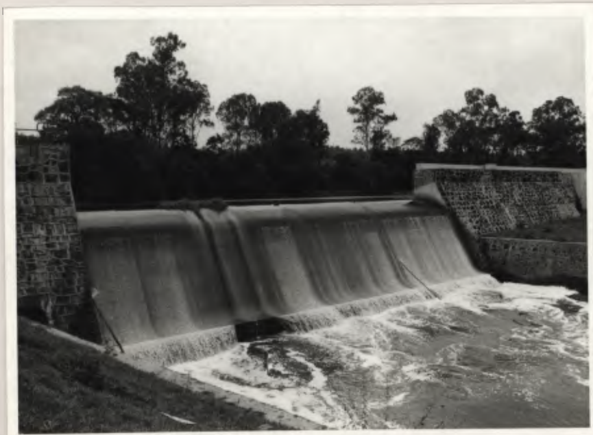
Barragem Ribeirão Claro.
