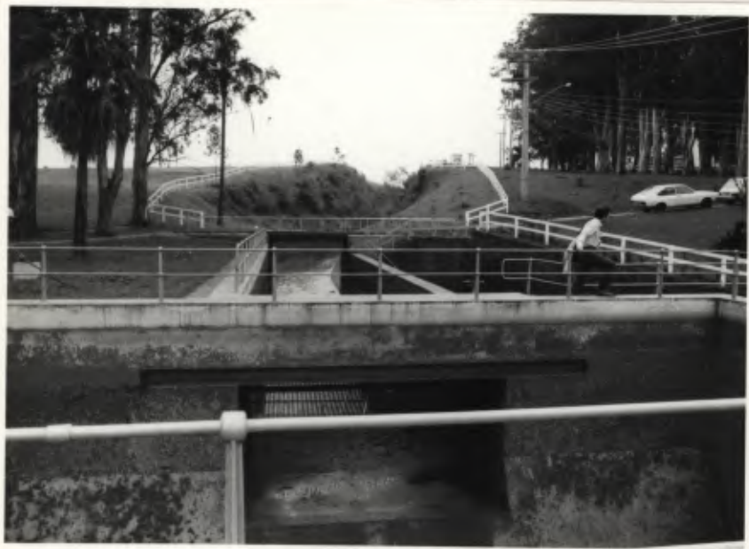
Vista do canal de desvio da câmara de estabilização.
