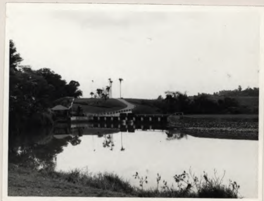
Vista geral da Barragem de Corumbataí.
