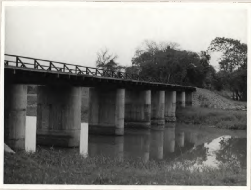
Ponte a montante da Barragem de Corumbataí. Reconstruída completamente os apoios que restavam.
