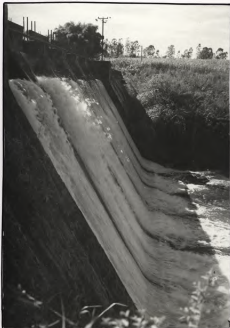
BARRAGEM RIBEIRÃO CLARO
