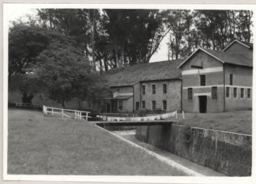
VISTA GERAL - CASA DE MÁQUINAS
