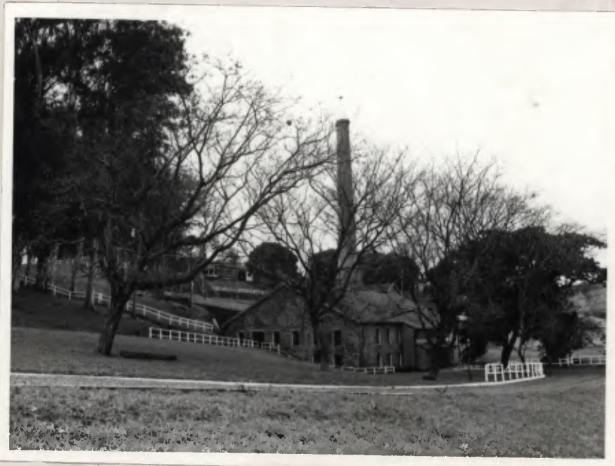
Casa de força.
