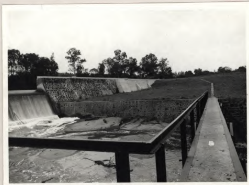
Vista da Barragem da passarela de pedestres.
