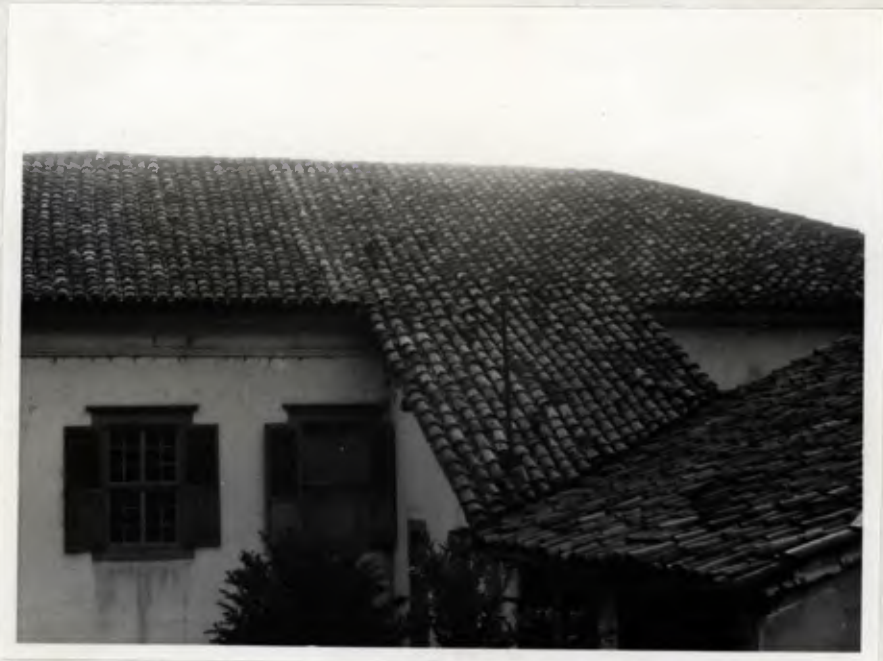
Vista do telhado
