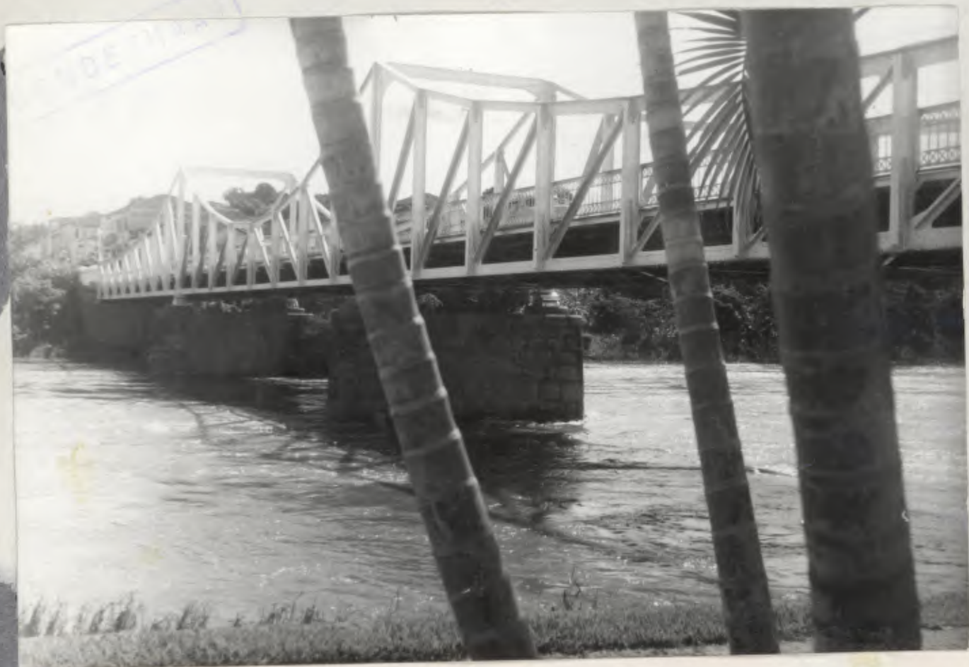
ASPECTO DA PONTE SOBRE O RIO PARÁ CONSTRUÍDA POR EUCLIDES DA CUNHA
