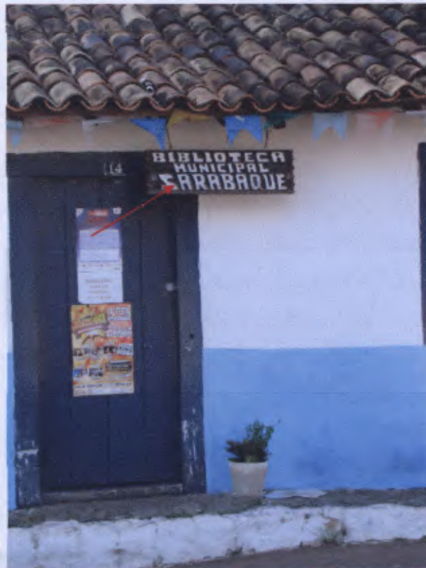
Foto 21: Placa de identificação do prédio da Aldeia de Carapicuíba.
