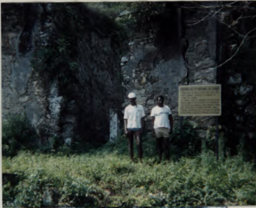
32 A Fotos DAS RUINAS DA CAPELA, ST. ANTONIO GUAIMBÉ
