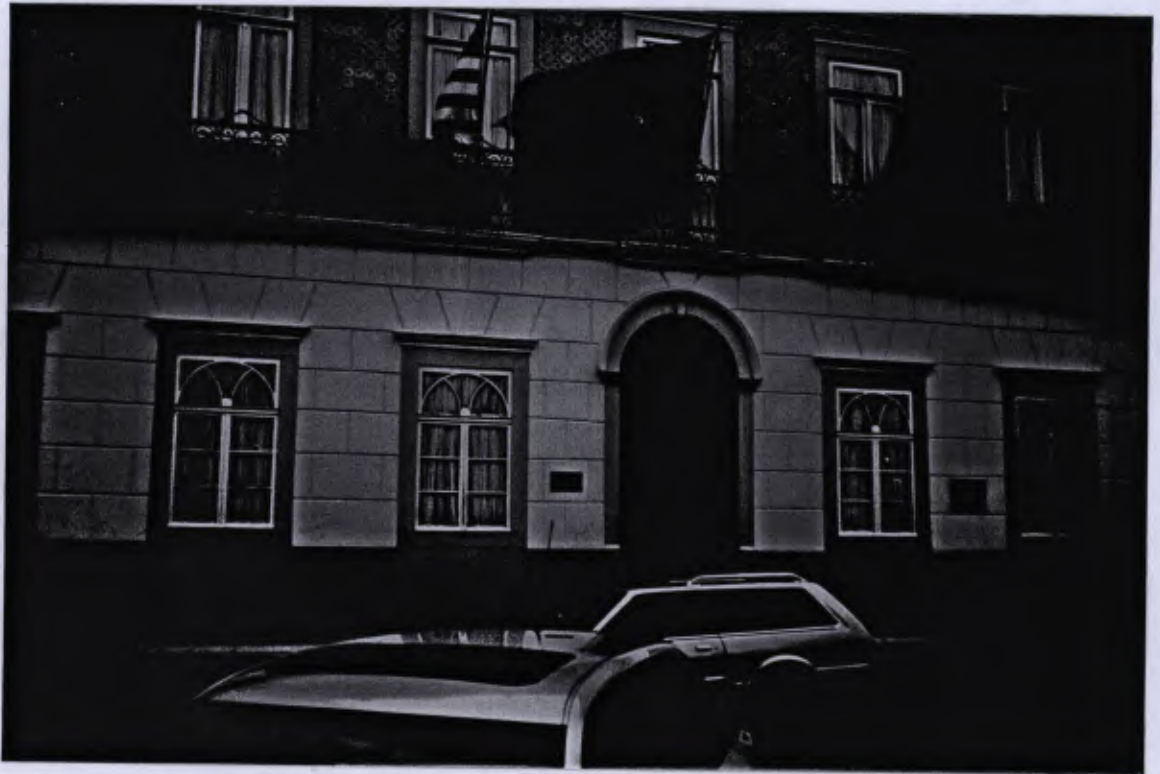
FOTO N° 02: Vista parcial da fachada do imóvel.
