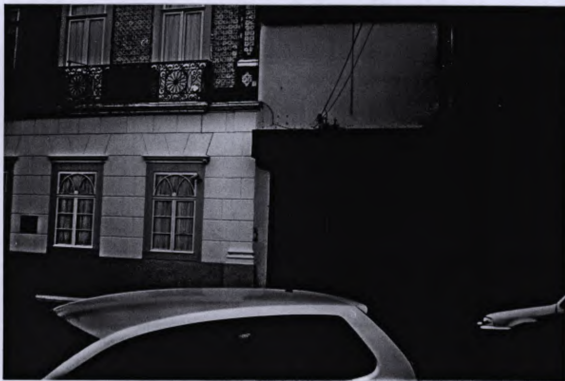
FOTO Nº 04: Vista parcial da divisa com imóvel, Rua Barão de Itaim, 89.
