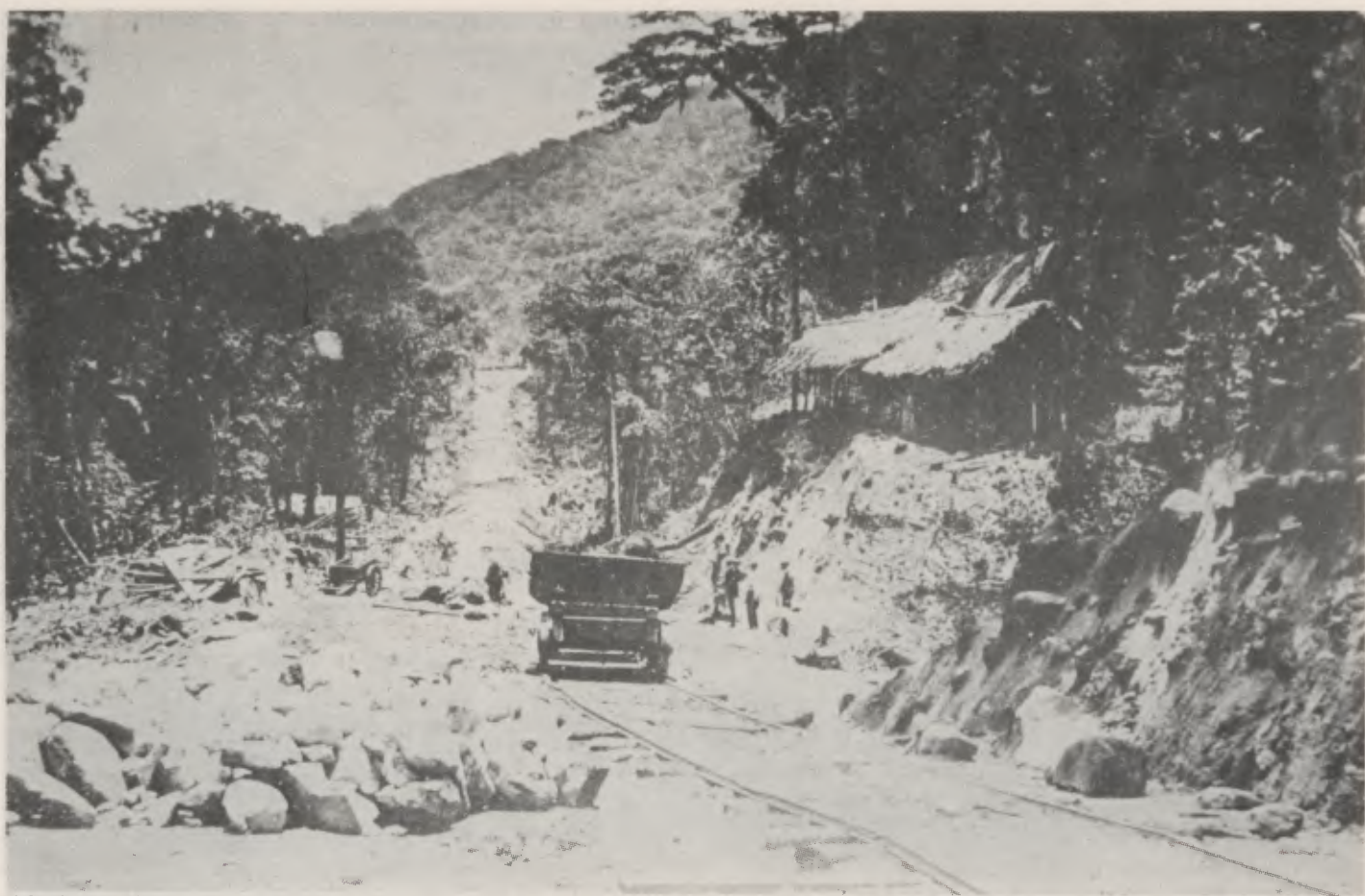
1860 - Obras na raiz da serra.
