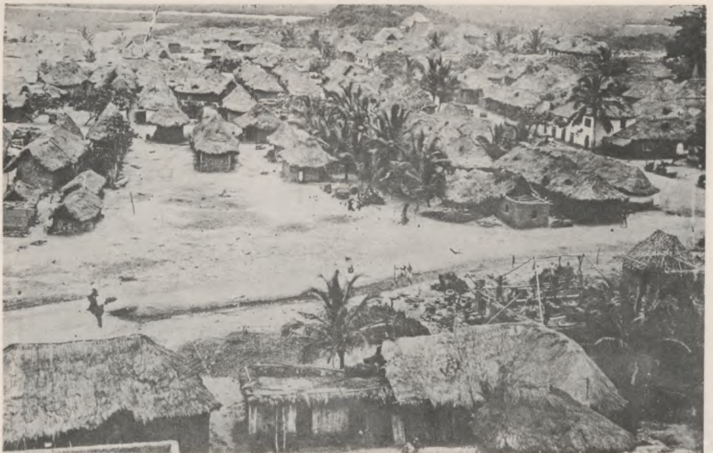
Acampamento dos engenheiros da S.P.R. em Santos, durante a construção da ferrovia, 1862-1863. 103
