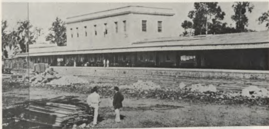
1890 - Vista da Estação da Luz (São Paulo).
