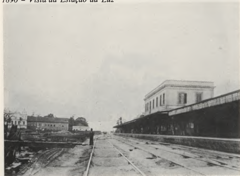
1890 - Vista da Estação da Luz (São Paulo).
