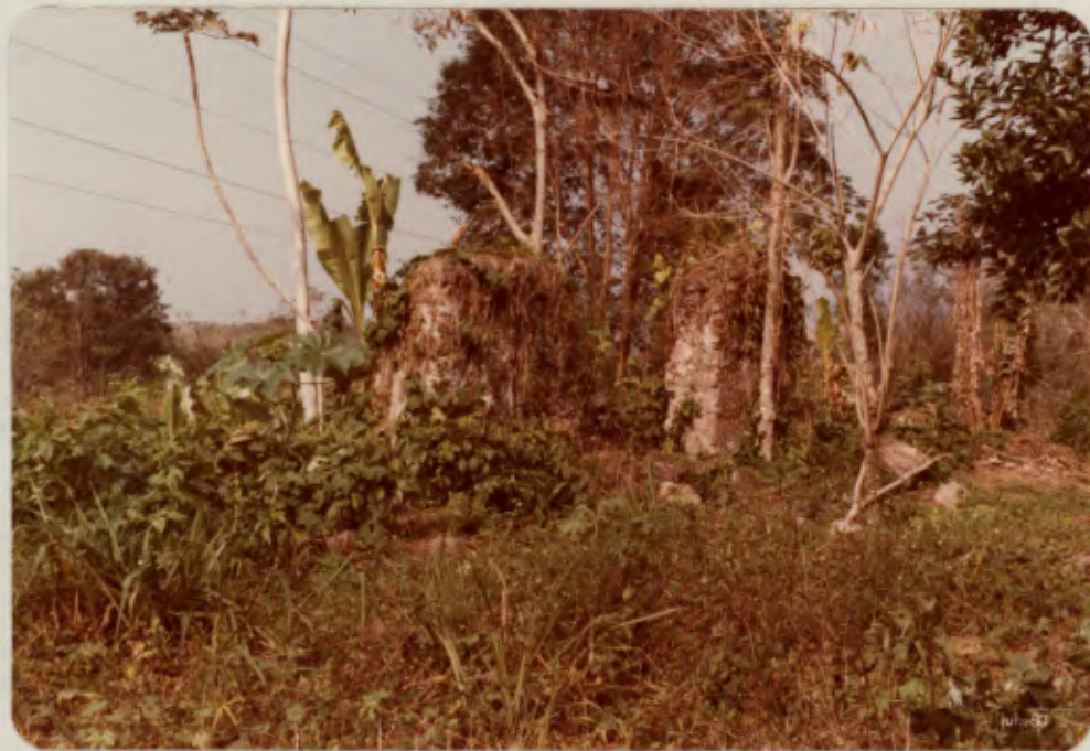
MURO EXISTENTE NA QUADRA Nº 1
