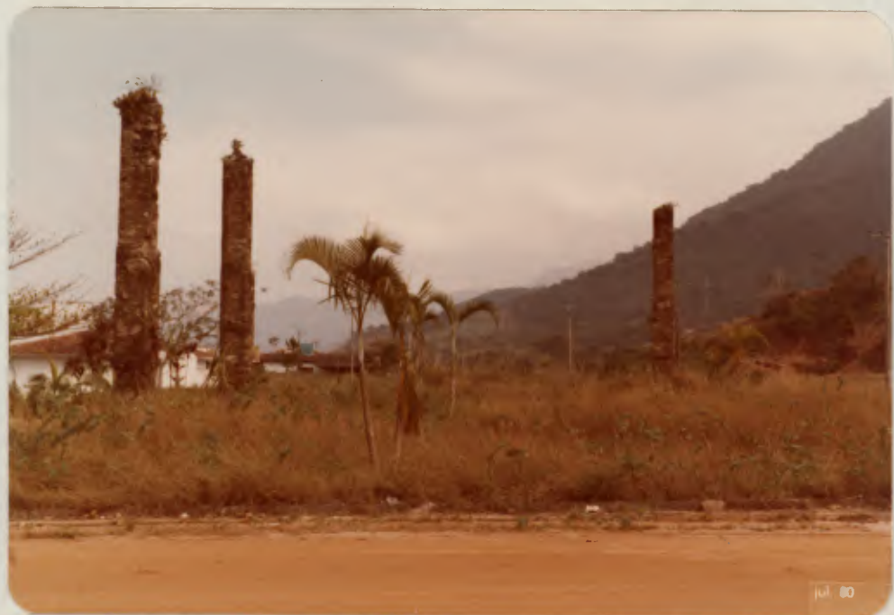
PILARES DA "FABRICA DE VIDRO" JUNTO A RODOVIA
