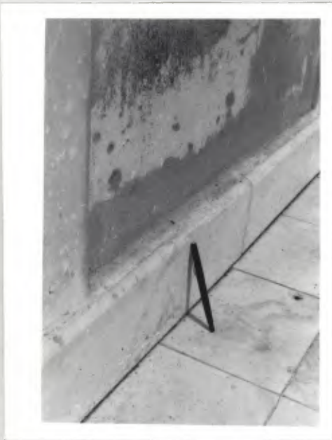
Detalhe de arremate do rodapé
