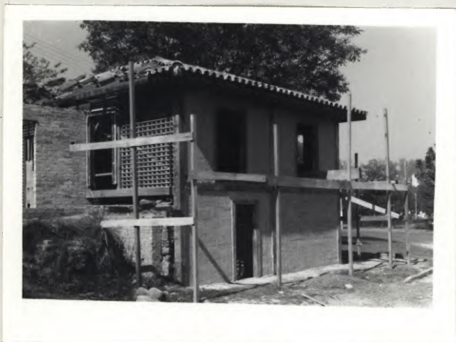
FOTO 1: Notar fachada frontal c/ argamassa de vedação aplicada. Faltando receber camada final de revestimento.
