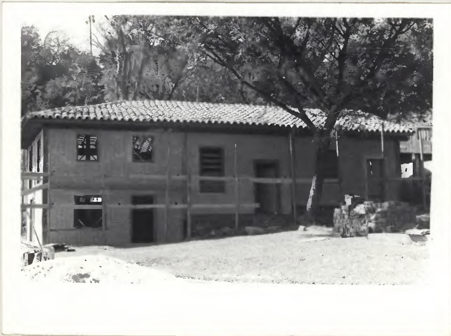
FOTO 2: Fachada c/ argamassa de vedação parcialmente executada
