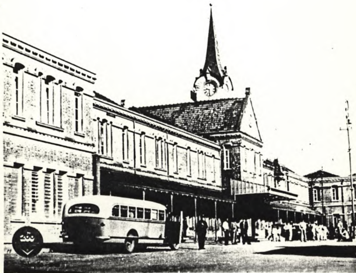
Fotografia de 1948. Nessa época já havia se iniciado a substituição dos caixilhos de madeira por caixilhos de ferro, como se pode observar nas janelas do pavimento térreo, à esquerda.
