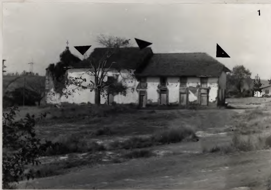
1. Setor Descoberto Setores aparentemente comprometidos
