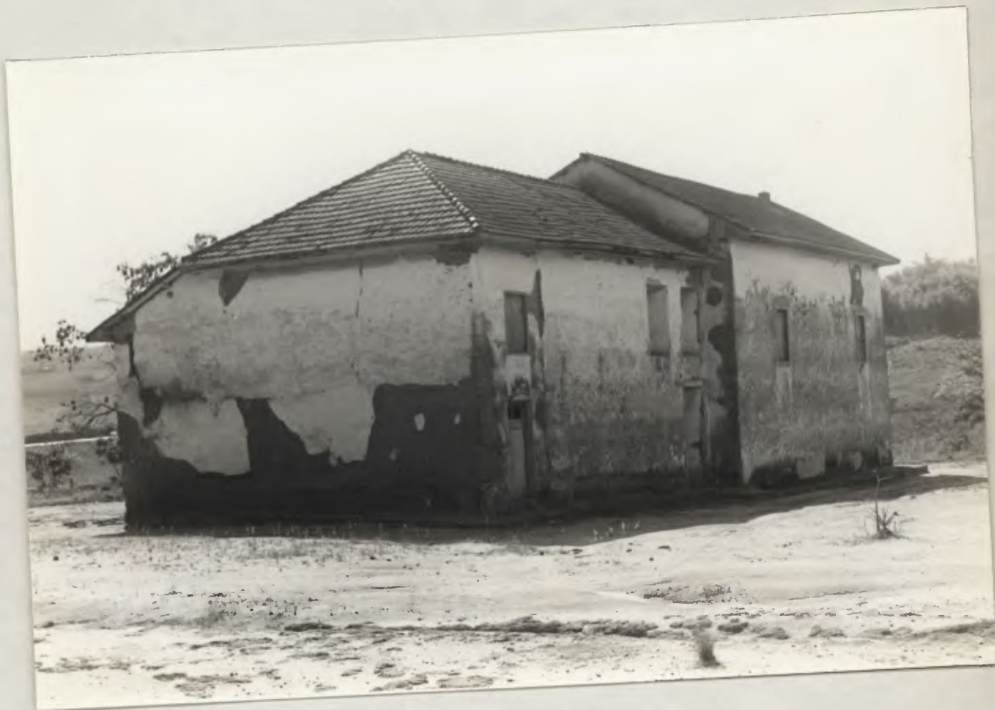
CAPELA DE NR S RA DOS REMÉDIOS
