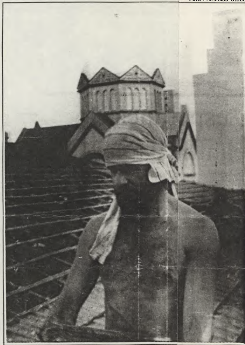
Operário trabalha no telhado do prédio antigo do Colégio Progresso, tombado pelo patrimônio histórico
