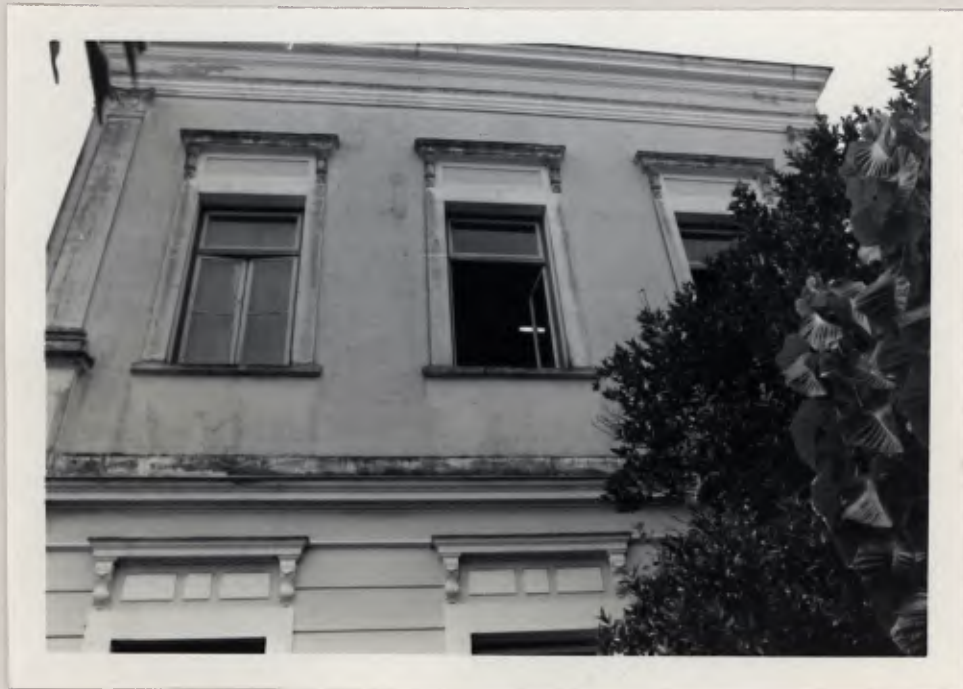
Fachada Fundos - Detalhe Segundo Pavimento
