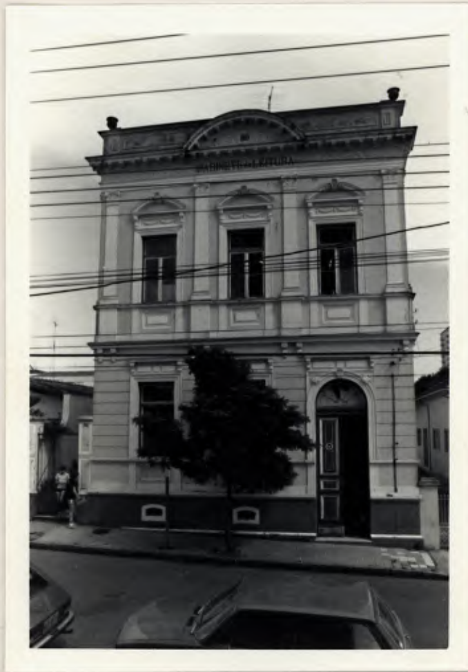
Gabinete de Leitura - Fachada Frontal
