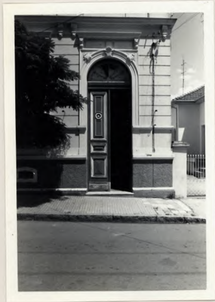
Detalhe da Fachada Frontal - Porta Principal
