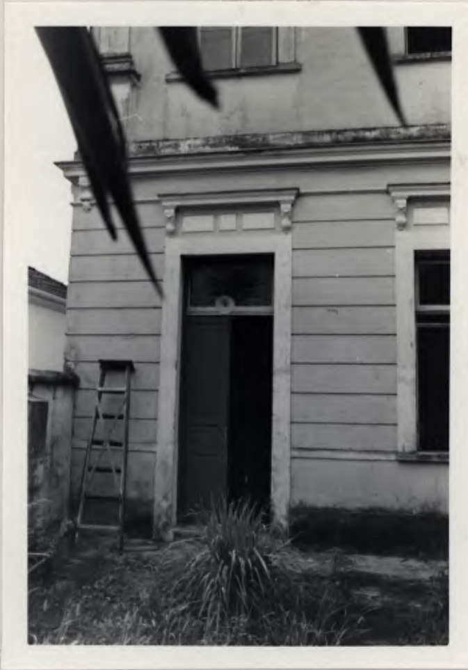
Fachada Fundos - Detalhe da Porta de Serviço
