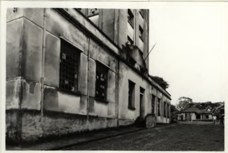
VISTA DO GALPÃO PRINCIPAL - FACHADA
