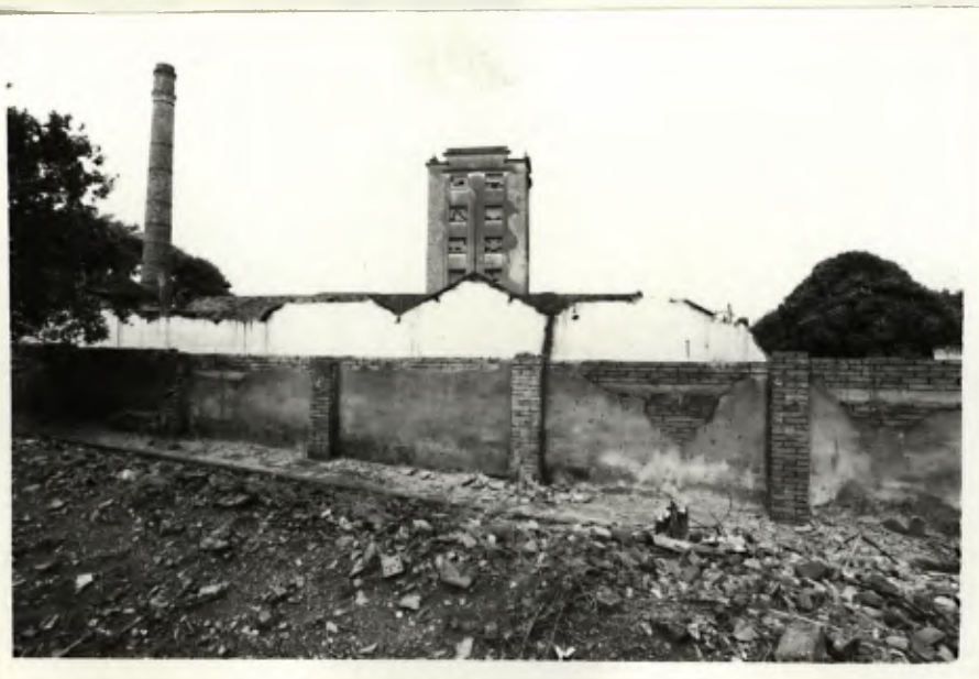
VISTA DE UM DOS GALPÕES SECUNDÁRIOS
