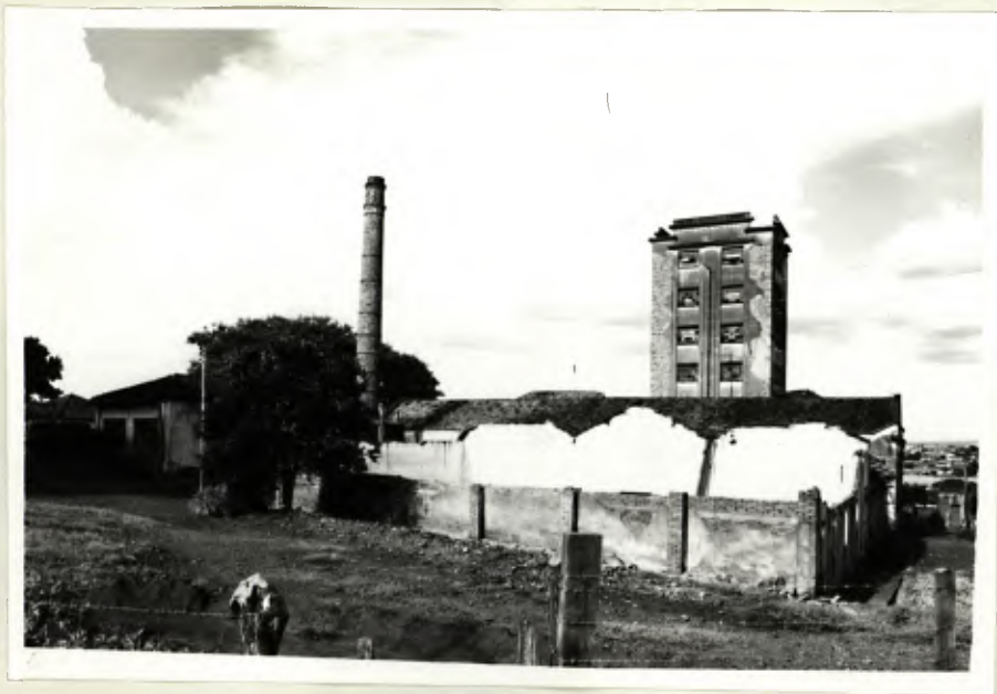
GALPÃO SECUNDÁRIO FUNDOS
