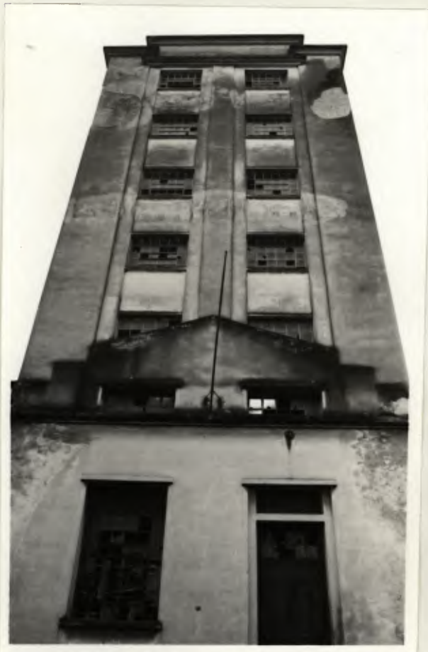
FOTOS DA EDIFICAÇÃO PRINCIPAL - TORRE QUE ABRIGA OS CONDUTORES.
