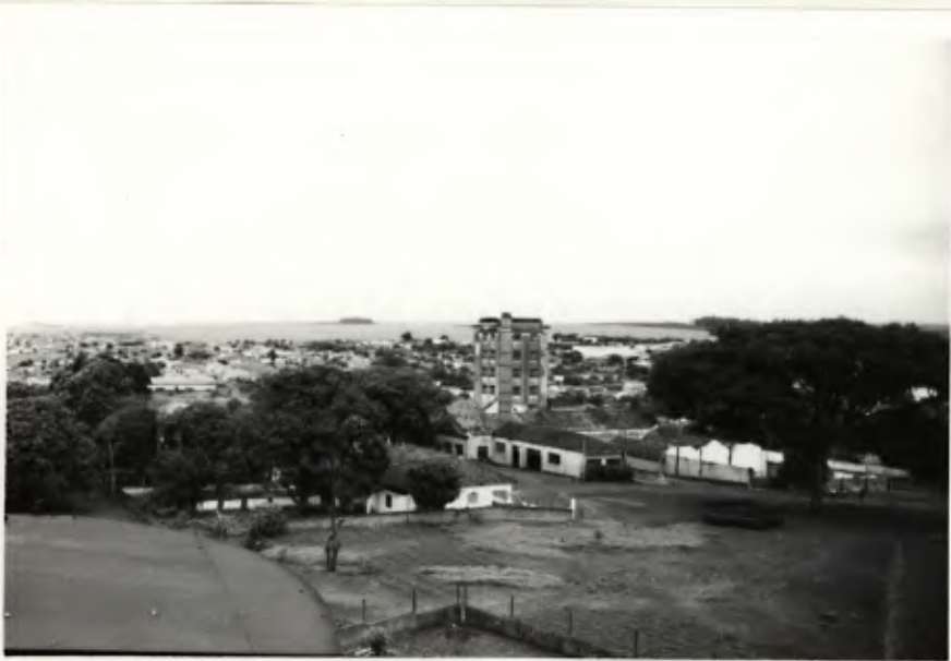
VISTA GERAL FOTO TIRADA DA REGIÃO DOS RESERVATÓRIOS EXTERNOS
