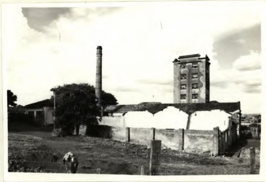
GALPÃO SECUNDÁRIO - FUNDOS
