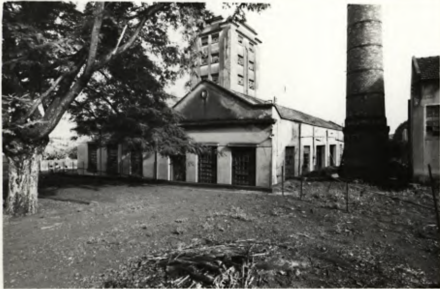
DIREITA LATERAL DO GALPÃO PRINCIPAL DETALHE : CHAMINE
