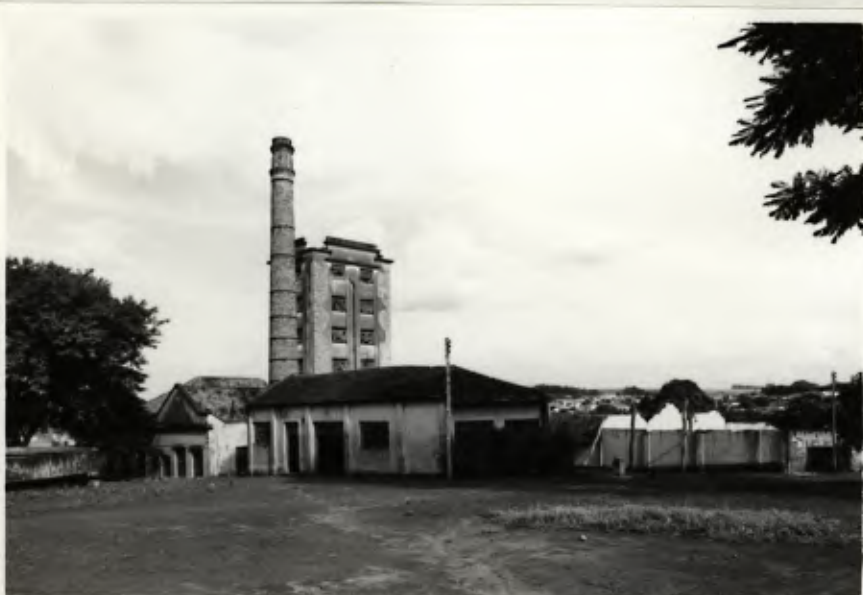
VISTA DE UM DOS GALPÕES SECUNDÁRIOS
