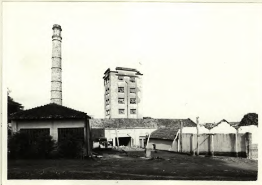
VISTA DOS 2 GALPÕES SECUNDÁRIOS - FUNDOS
