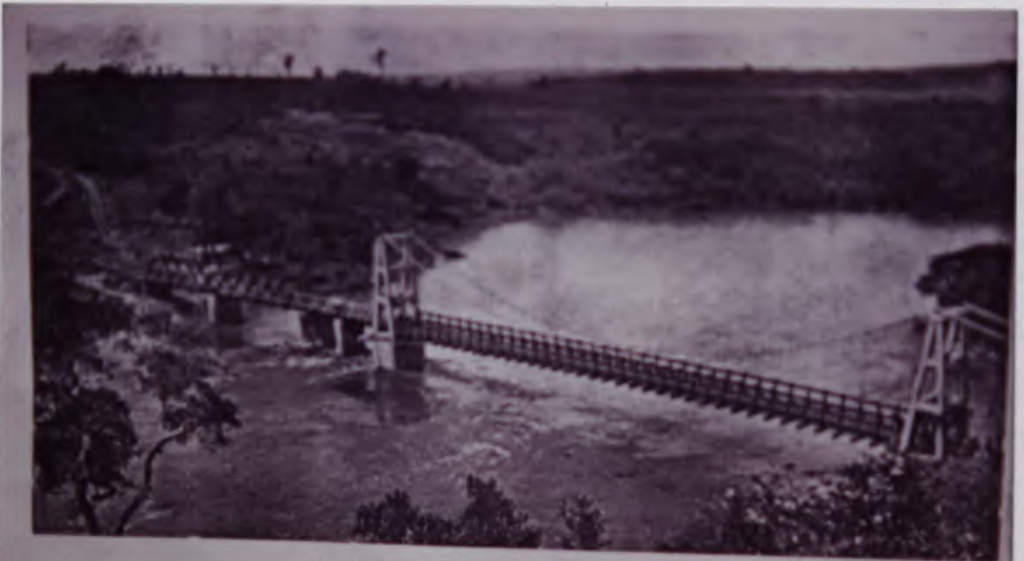
Vista geral da ponte
