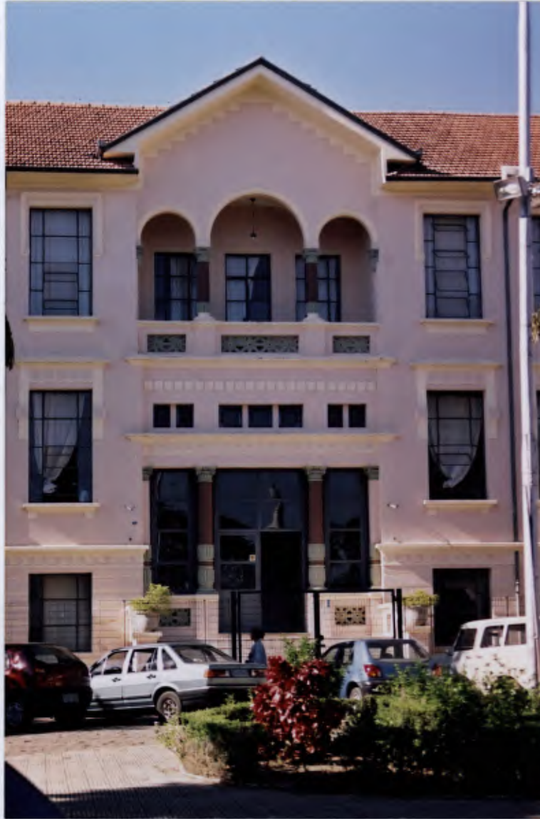
FOTO 27 - FACHADA FRONTAL - DETALHE
