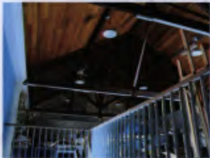
Detalhe das tesouras e cobertura (Art. 1º, I)
