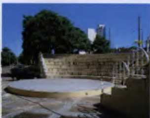
Arquibancada em frente ao acesso da estação
