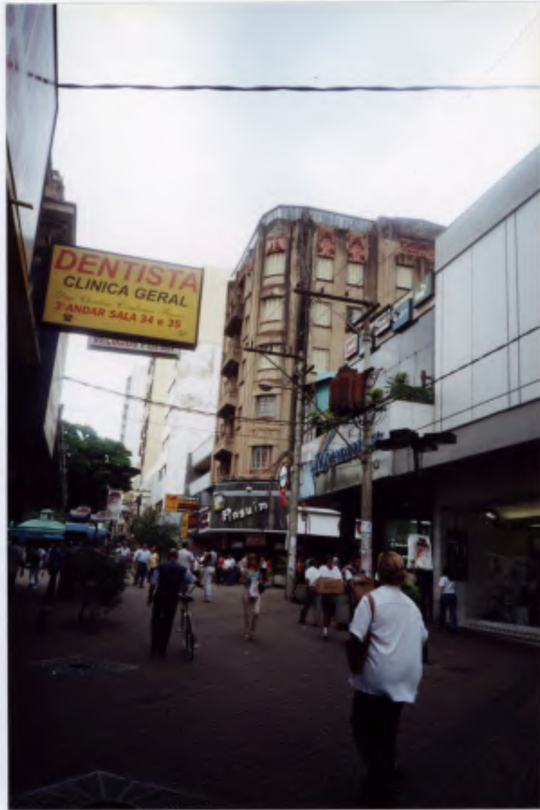
FOTO 8 EDIFÍCIO DIEDERICHSEN VISTO A PARTIR DA RUA GENERAL OSÓRIO
