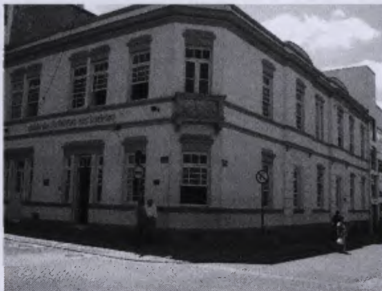
Fachada do Gabinete de Leitura Ruy Barbosa, com implantação de esquina Fotografia Walter Fragoni. 06. 01.2009
