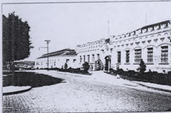
Quartel da Guarnição Militar Federal de Jundiaí, localizado à Rua do Rosário, 1940.
