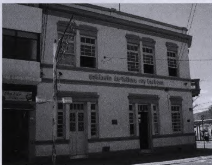
Fachada principal do Gabinete de Leitura Ruy Barbosa. À esq., o corpo constituído pela primeira porta e duas janelas superiores consta ser de antiga residência adquirida e incorporada pelo Gabinete. Consta ainda que ali fora o cemitério da antiga Igreja do Rosário. Fotografia de Walter Fragoni
