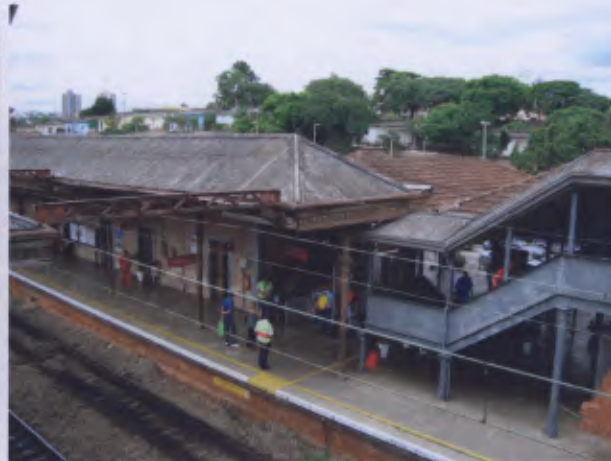
Estação: área de acesso, cobertura e passarela metálica (Art. 1º inciso I)
