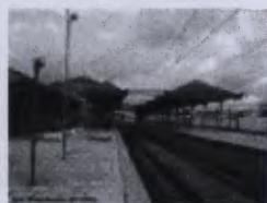
Estação de Jundiaí, tirada sentido interior. Foto Rafael Asquini em 25/12/2008
