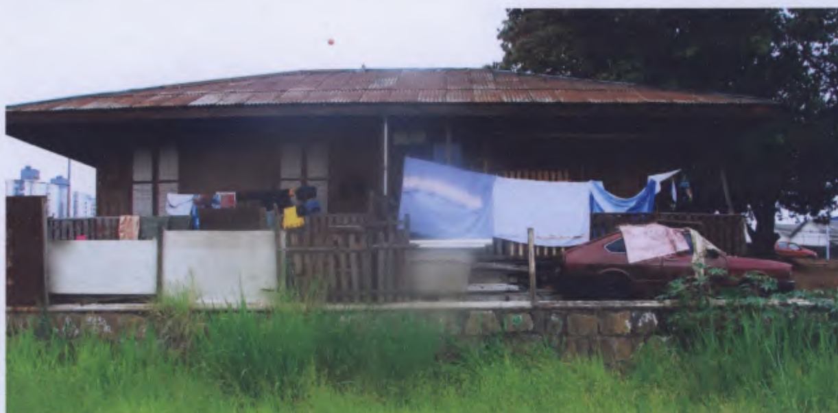
Vila ferroviária (vila de funcionários): destaque para as fundações em pedra e as fachadas e caixilharia em madeira (Art. 1º inciso IX)
