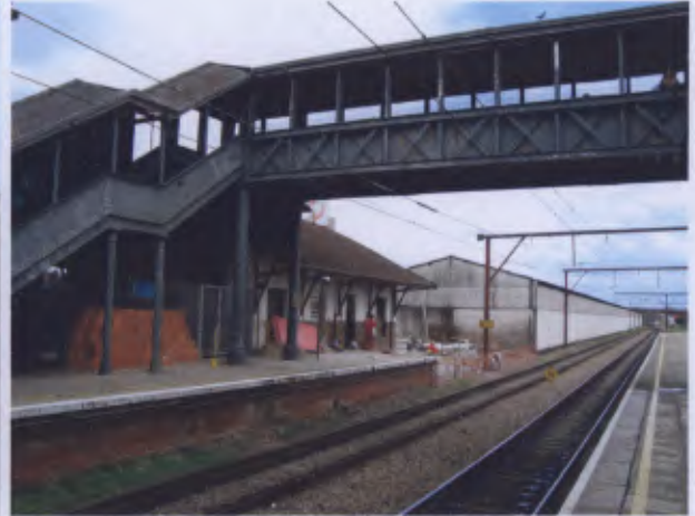
Estação: passarela metálica (Art. 1º inciso I) com Armazém da companhia Paulista de Estrada de Ferro ao fundo (Art. 4º inciso V)
