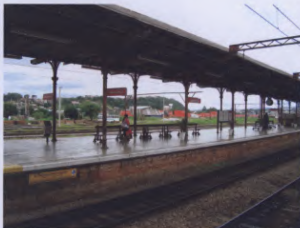
Estação: plataforma - destaque para fundação em alvenaria e cobertura (Art. 1º inciso I)
