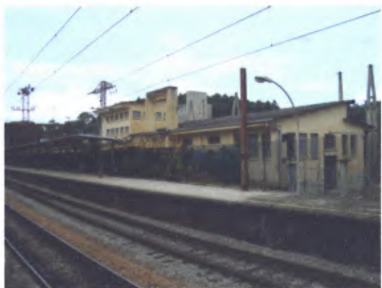
Autor: Arq. José Antonio C. Zagato Foto realizada em 15.01.2010 Subestação elétrica: local previsto de passagem do viaduto (Vista norte)
