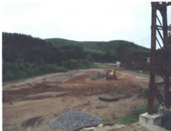
Autor: Arq. José Antonio C. Zagato Foto realizada em 15.01.2010 Vista geral da terraplanagem, com estrada à direita
