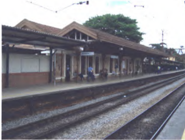
Estação: plataformas – destaque para fundações em alvenaria (Art. 1º inciso I)
