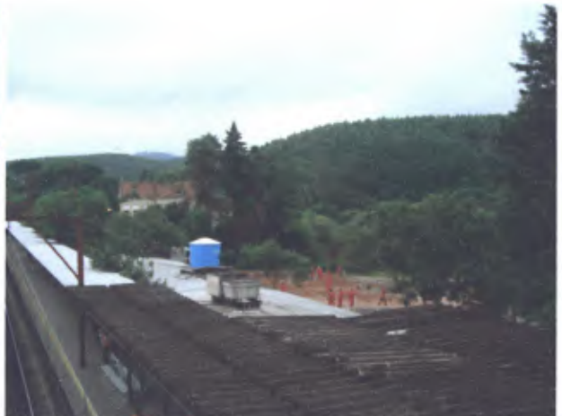
Área envoltória (Art. 4º inciso I, III, e IV) Área verde e Armazéns da Companhia Melhoramentos
