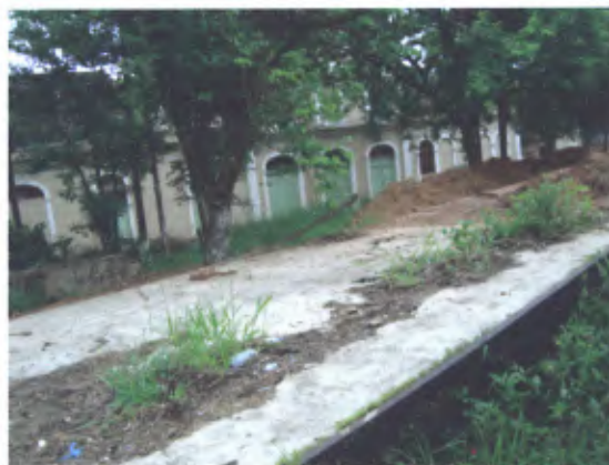
Autor: Arq. José Antonio C. Zagato Foto realizada em 15.01.2010 Ramal da Cia. Melhoramentos paralelo à via férrea oeste, com edifício original ao fundo
