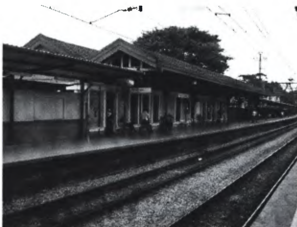
Estação: plataformas – destaque para fundações em alvenaria (Art. 1º inciso II)
