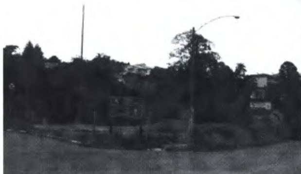
Entorno: Obras do viaduto iniciadas no lado leste da via férrea
