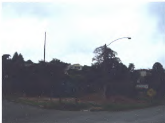
Autor: Arq. José Antonio C. Zagato Foto realizada em 15.01.2010 Terraplanagem iniciada no lado leste da via férrea
