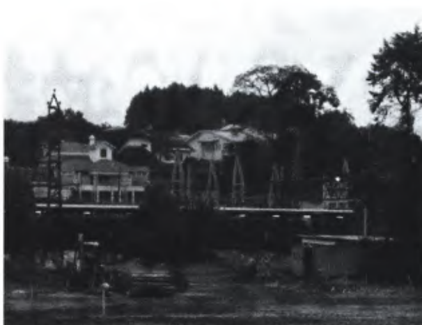
Área envoltória (Art. 4º inciso I): Vista da terraplanagem, com estação ao fundo
