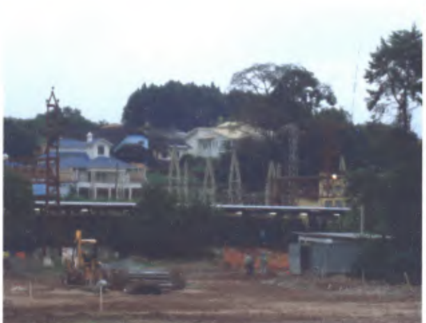
Área envoltória (Art. 4º inciso I): Vista da terraplanagem, com estação ao fundo
