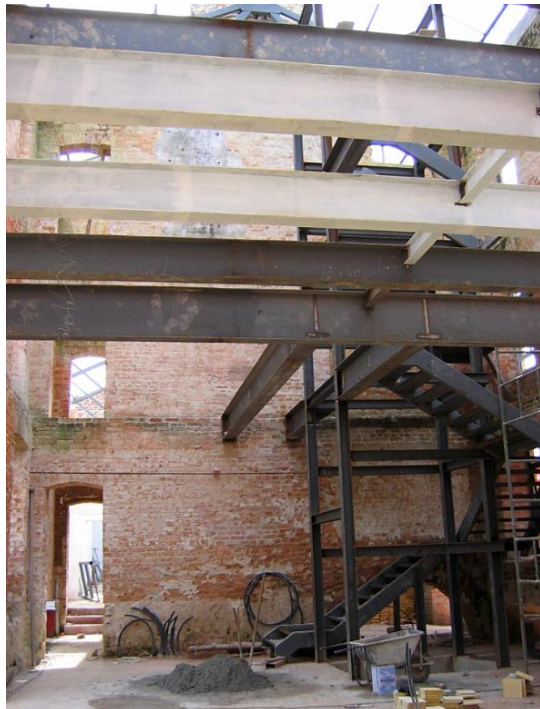
Figura 26: Foto mostra a instalação de vigas de aço carbono resistentes à ação corrosiva do sal e até hoje permanecem firmes no local, 2004. Foto cedida por Perrone e Associados.
