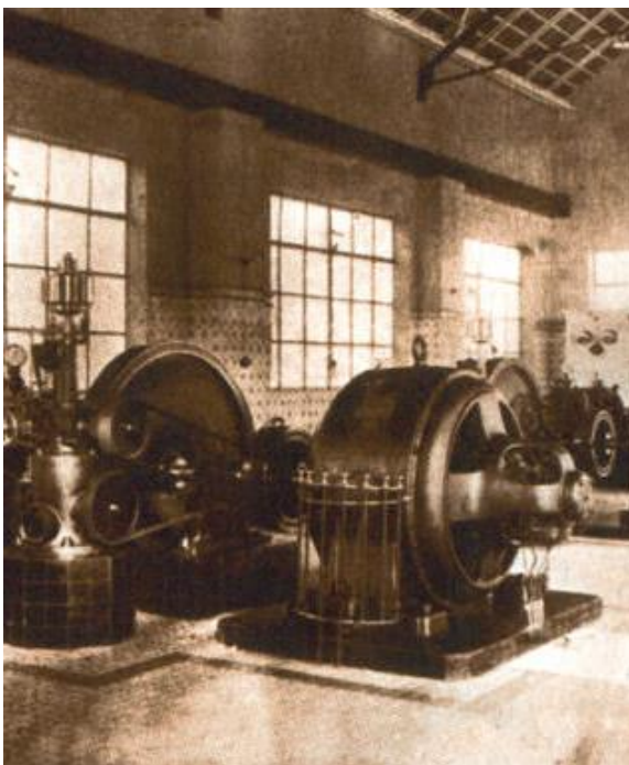
Figura 10.: Exemplo de dínamo que compunha a casa de máquinas do moinho. Ribeirão Pires não tinha energia elétrica e a luz do prédio industrial era gerada por esse tipo de equipamento. À direita, máquina de moenda de cilindro, fabricada pela Ganz & Co., utilizada no Moinho de Ribeirão Pires. O cilindro foi a principal inovação tecnológica trazida pelos Maciotta em um mercado ainda incipiente em São Paulo. Google Imagens.
