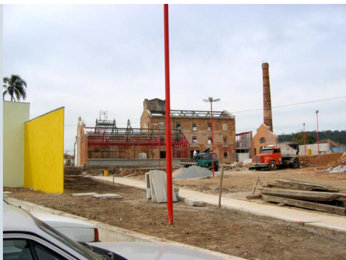
Figura 31: Canteiro de obras, 2004. Foto cedida por Perrone e Associados.
