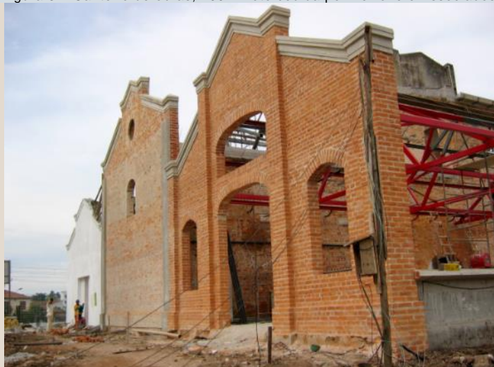
Figura 32: Pórtico do galpão reconstruído segundo características originais, 2004. Foto cedida por Perrone e Associados.
