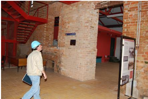
Técnico do IPT em visita técnica ao edifício Dom Helder Câmara.
