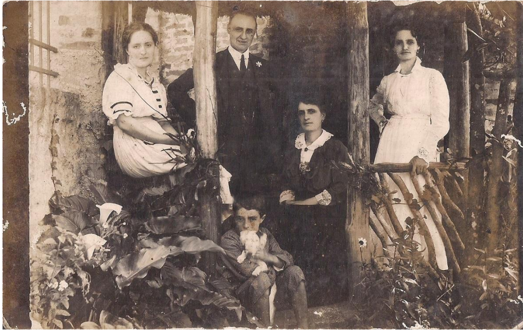
Figura 14: Fotografia tirada na casa construída nas dependências do moinho. Vemos Federico, com seu habitual terno e cravo na lapela, Antonietta, sua esposa (sentada), Eugênia (de branco, em pé). Sentado com seu cachorro, Júlio Maciotta, filho de Ottavio. Sentada sobre o gradeamento de madeira da varanda, de vestido branco, uma mulher não identificada. Coleção Raul Maciotta.
