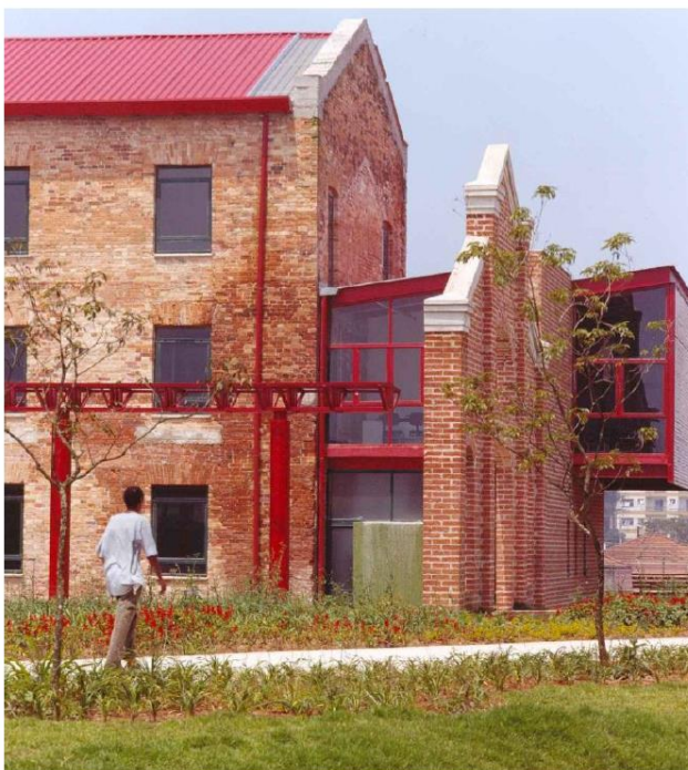
207. Fachada lateral – pavilhão 2 com destaque para a sala de aula em balanço.
