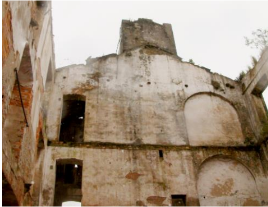
Figura 23: Paredes internas do início das obras, 2004. Foto cedida por Rafael Perrone.
