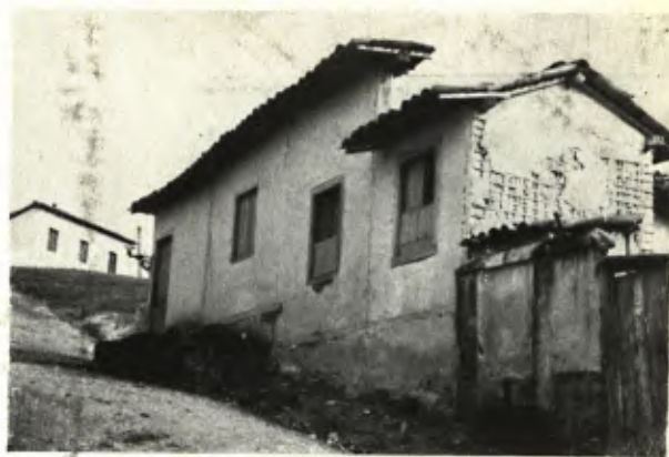
Parede postiça quadrando a fachada
