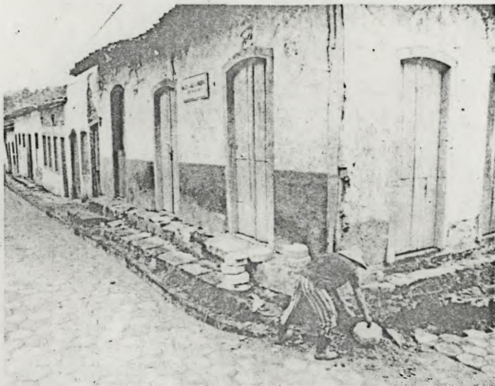
As obras de restauração começarão na semana que vem, depois de pronto plano de emergência.
