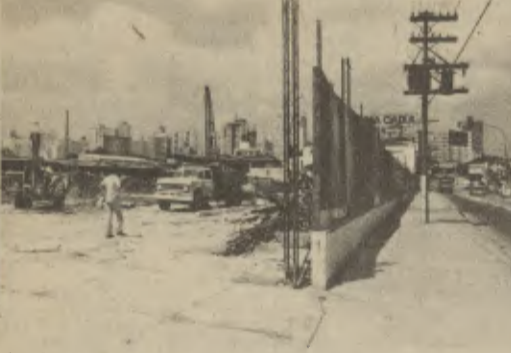
A obra da Hermes Macedo prossegue
