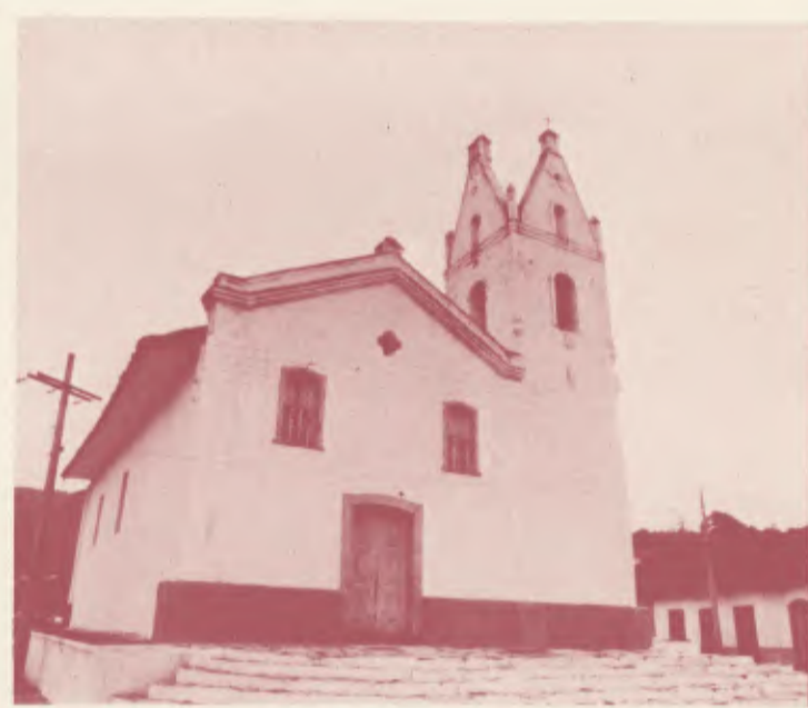
A Igreja matriz de Santana de Iporanga foi construída por volta de 1820, com grossas paredes de taipa. A torre foi acrescentada em 1884 pelo alemão Guilherme Loozer, "construtor de igrejas" nomeado pela Santa Sé e que, para as obras de Iporanga, recebeu uma contribuição de D. Pedro II. O sino foi doado por Joaquim Mota, comerciante local; tem ótima sonoridade e consta que dois quilos de ouro do ribeirão Iporanga foram misturados ao bronze durante a fundição. A escadaria semi-circular de pedra, que se vê na frente da Igreja, é o terreno predileto dos moradores para o jogo-da-onça, brincadeira que se joga usando como peça as sementes conhecidas como olho-de-boi e olho-de-cabra ou pequenas pedras. (Foto Clayton Ferreira Lino, 1978).
