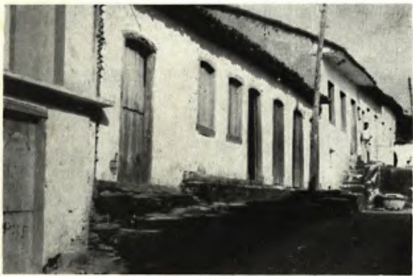
Calçada escalonada a moda mineira -
