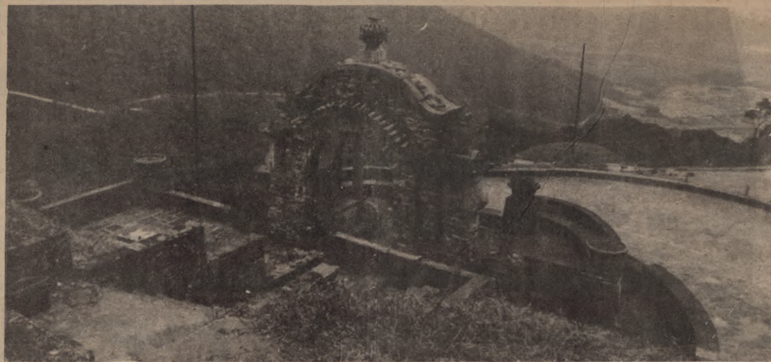
O calçamento foi trabalhado com lajes de granito na parte fronteira do monumento Padrão do Lorena. Com asfalto ele seria desfigurado.
