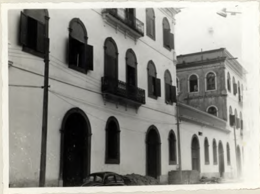
Fachada posterior, lado da Rua Comendador Neto. Reforma concluída.
