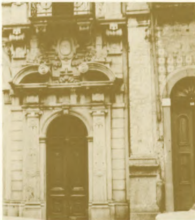
Rua do Comércio 100, detalhe da fachada - 1978. Foto Olívia Saraiva Valdívia/Ornella Regina Flândoli. Acervo Prodesan S.A.
