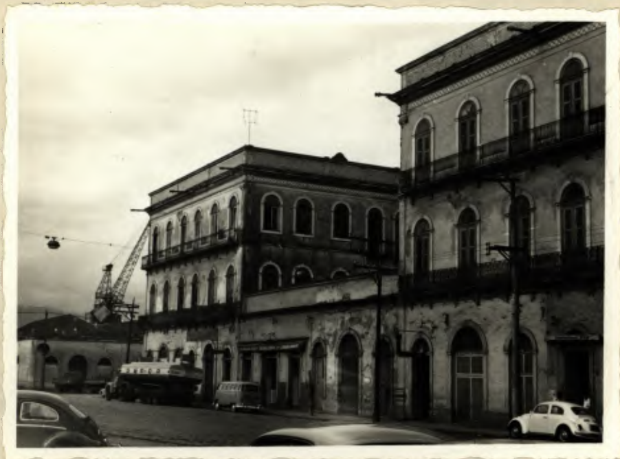
Ainda com características originais
