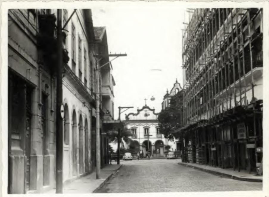
Rua do Comércio - ao fundo, Igreja de Santo Antonio do Valongo, monumento tombado pelo IPHAN. À direita, os andaimes já colocados no prédio da antiga prefeitura.
