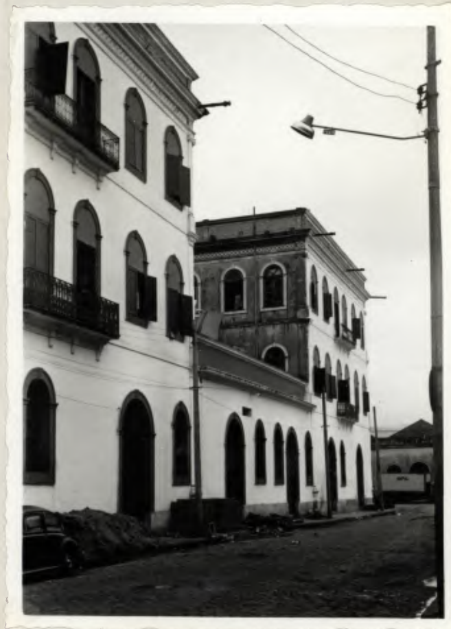
Foto tirada em 21/4/1974. Note-se a retirada das bandeiras das portas e vidraças com diminuição daquelas e colocação de venezianas, características do século XX. Uso da cor azul marinho nas platibandas superiores, inclusive na parte central. Alteração da cor do contorno das janelas e portas de clara para azul marinho.
