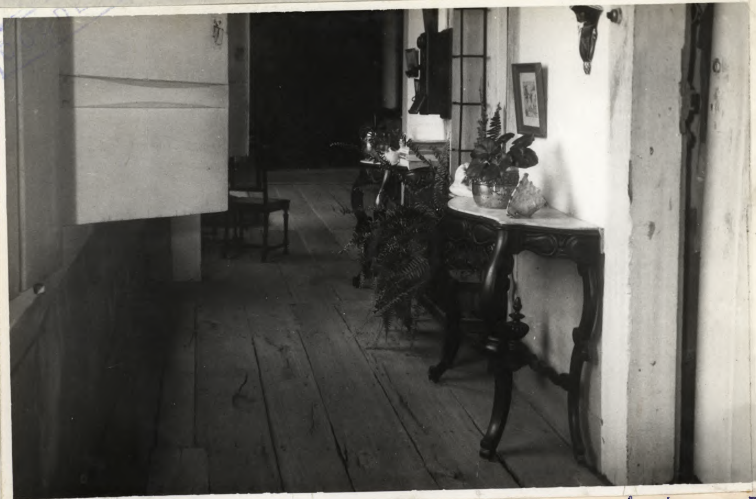
Corredor externo - (fs. 10) - vendo-se os móveis e ao fundo a porta do Oratório
