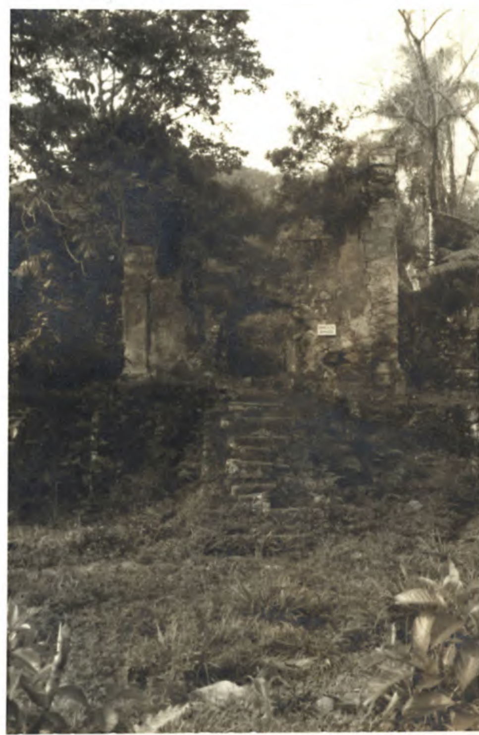
Vista da escadaria de acesso e fachada
