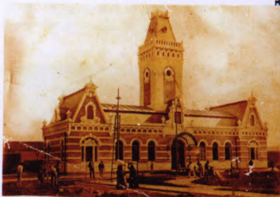
Estação Ferroviária em 1914, alguns dias antes de sua inauguração - Acervo Museu Frei Galvão e Foto da Estação Restaurada por Julio Maziero.
