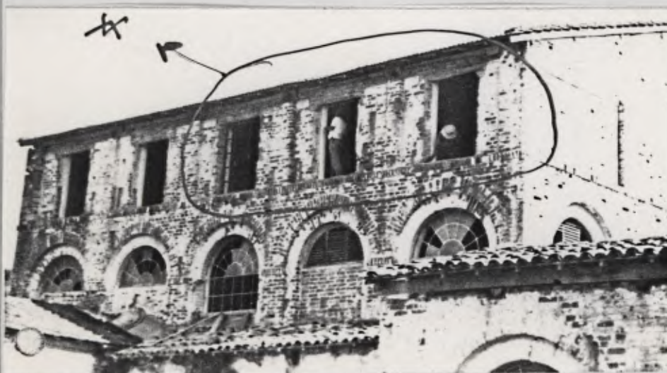
Cópia da foto/denúncia deste processo: "Alterações das janelas superiores para instalação do departamento de obras do município" p.11
