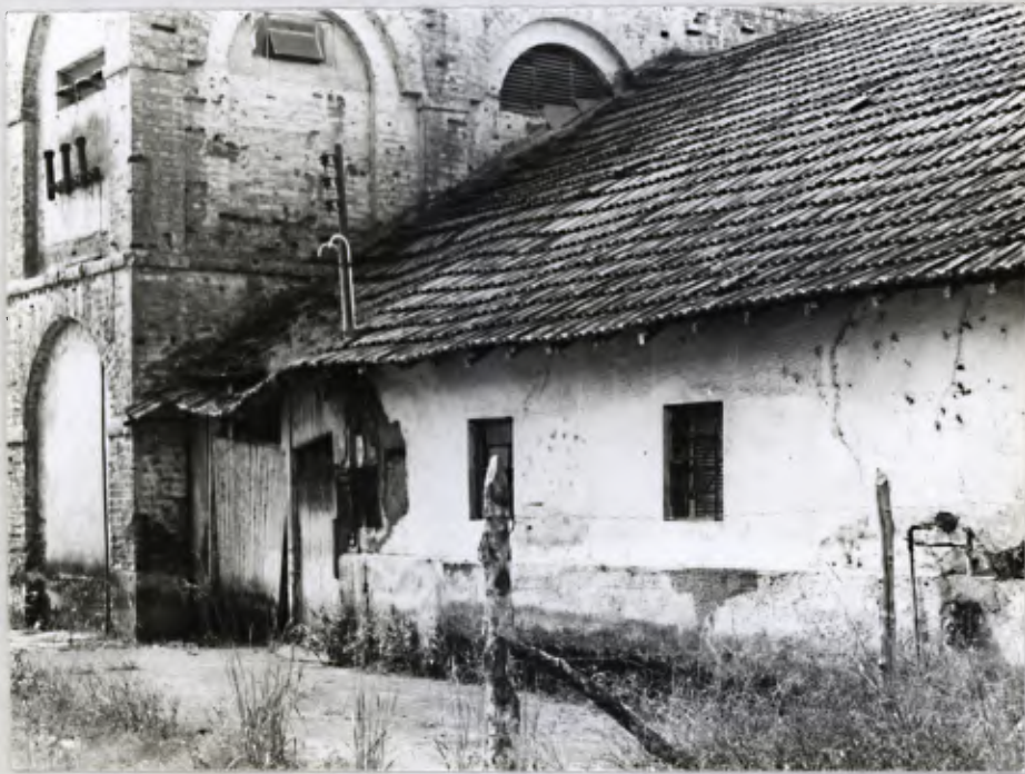
Construção anexa a ser demolida
