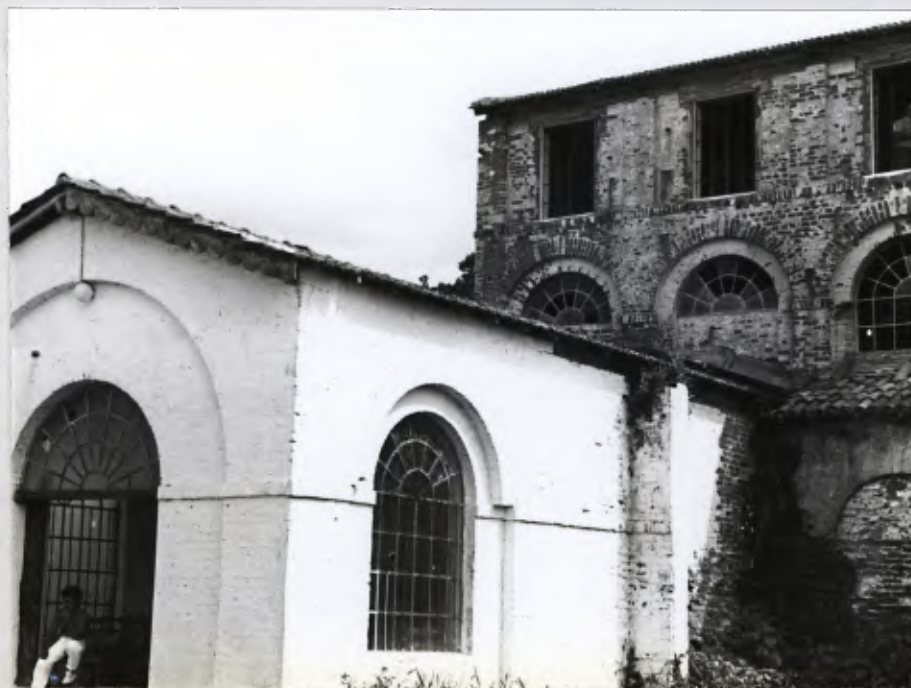
Área utilizada provisoriamente pelo Sindicato dos Trabalhadores na Construção Civil
