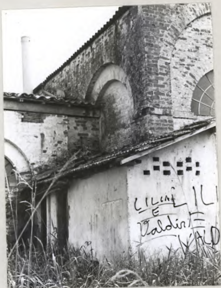
Anexo a ser demolido
