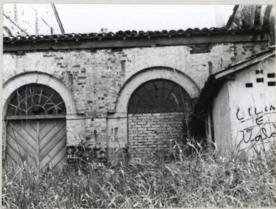
Parte de galpão ainda recoberto com telhas originais
