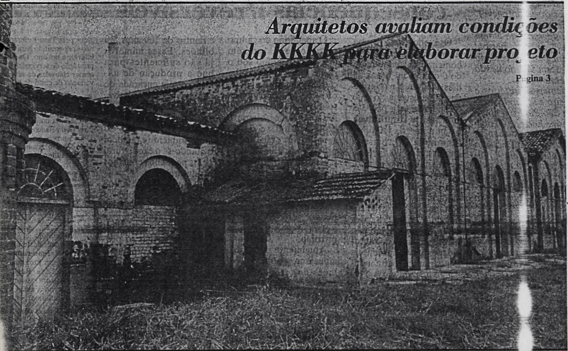
conservação do prédio facilitará a restauração
