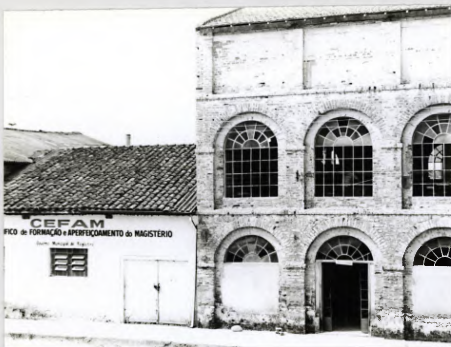
Área utilizada provisoriamente pelo Depto. de Obras e Serviços Municipais
