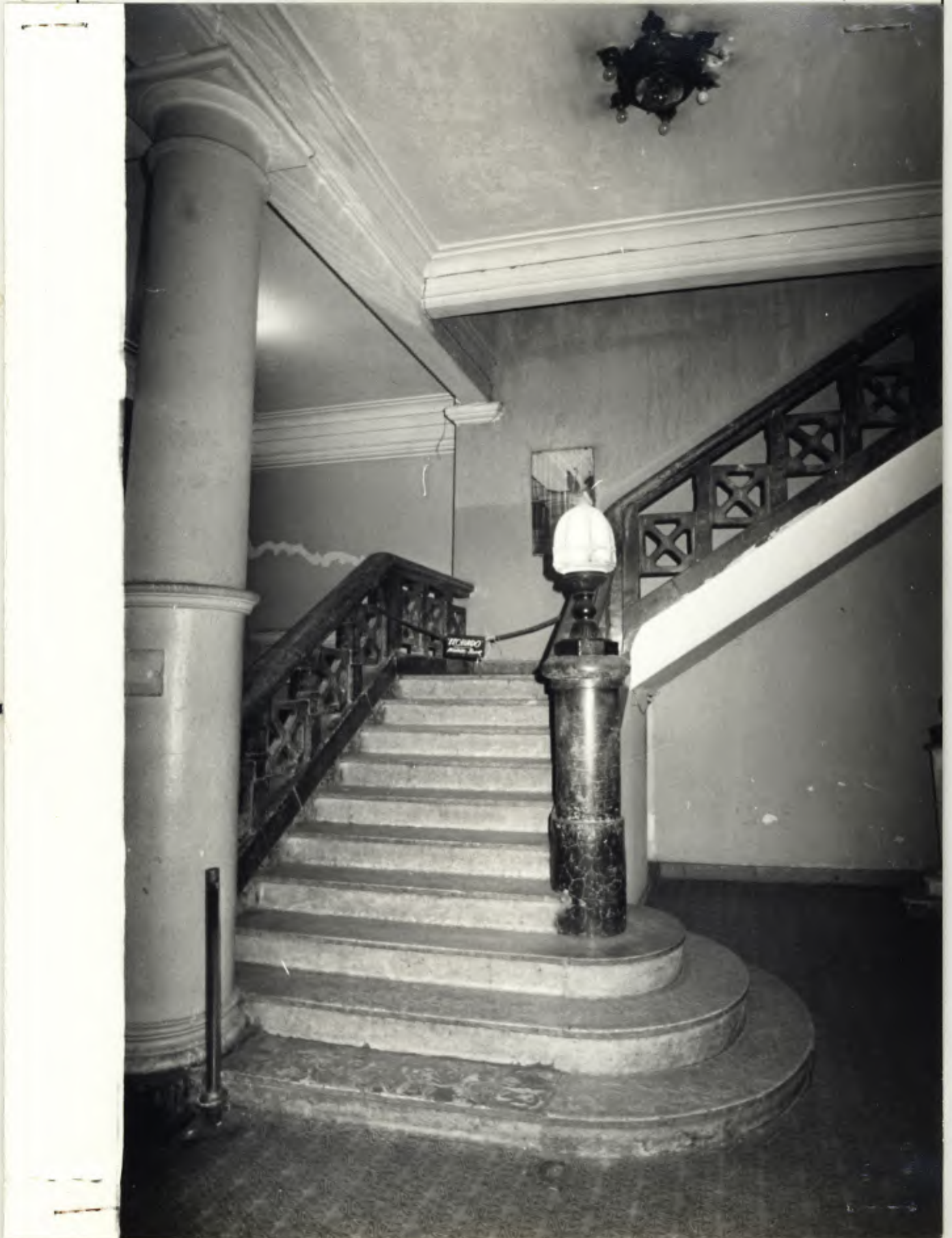
DETALHE DA ESCADARIA - ESTADO EM QUE SE ENCONTRAM OS "MATERIAIS NOBRES EMPREGADOS NO ACABAMENTO"-Equivalente ao DOC. 23
