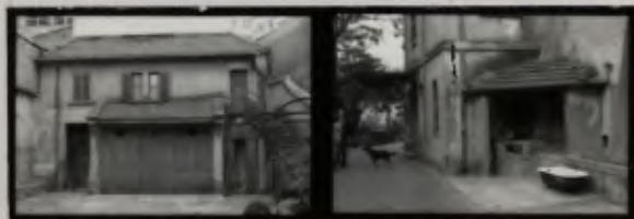
GARAGEM CASA DO CASEIRO
