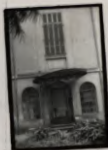
ACESSO DOS FUNDOS
