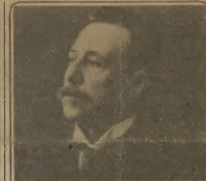
A de outro arquiteto, Ramos de Azevedo, autor do projeto do Teatro Municipal, uma casa que ficava na rua Pirapitingui, já foi demolida há cerca de três anos.
