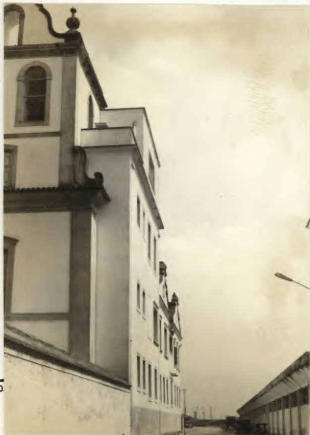
VISTA LATERAL MOSTRANDO AMPLIAÇÃO DA CONSTRUÇÃO
