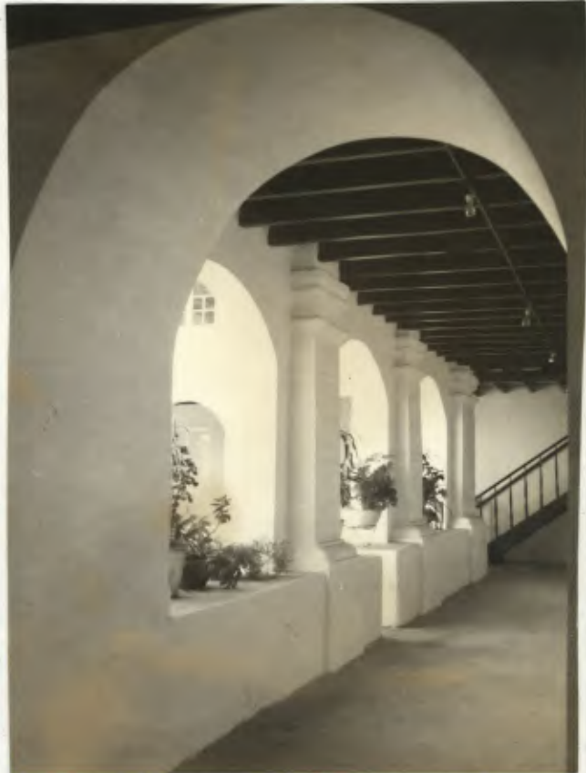
PAVÃO COBERTO / ORDEM 3ª - CLAUSTRO
