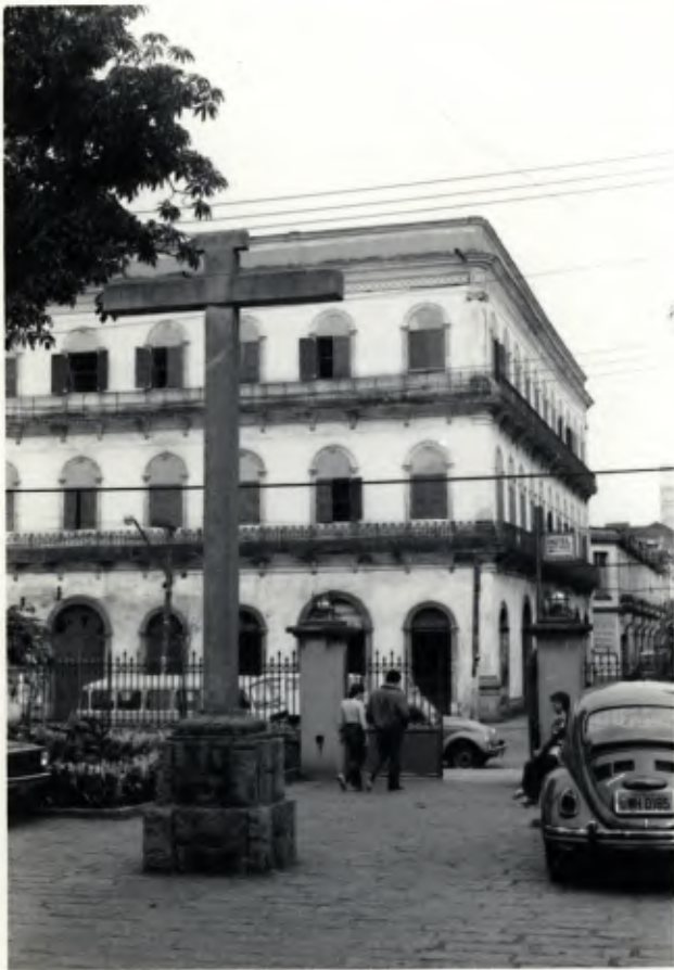
FOTO 4 CASARÕES DO LARGO MARQUÊS DE MONTE ALEGRE - FOTO TIRADA DA IGREJA DO VALONGO
