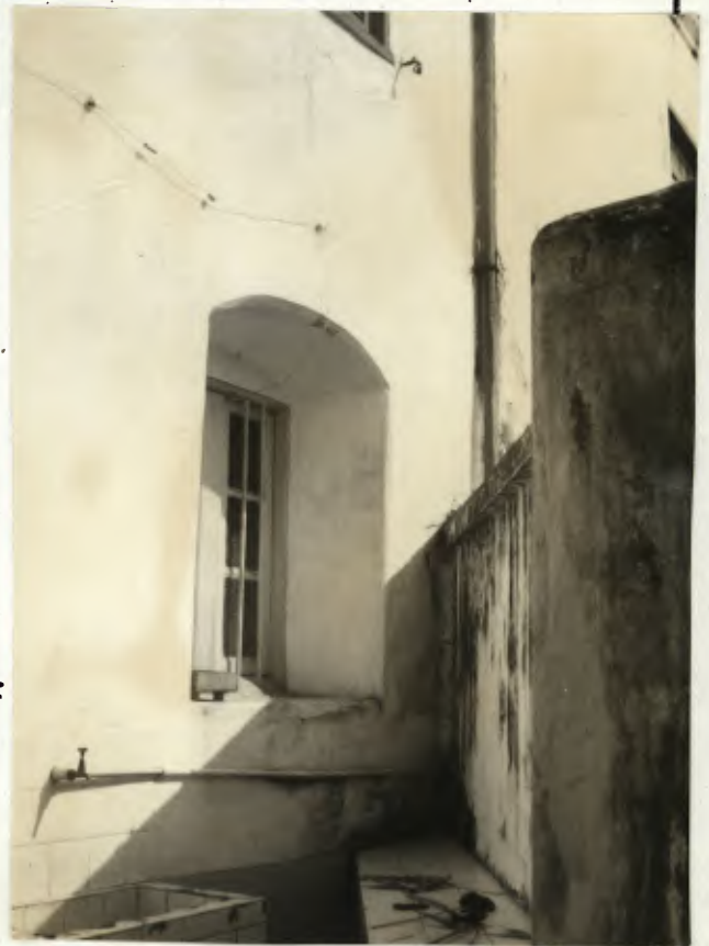
FOTO TIRADA NA ÁREA DESCOBER- TA EM FRENTE AOS SANITÁRIOS DO PAVIMENTO TERREO DA IGREJA DO VALONGO
