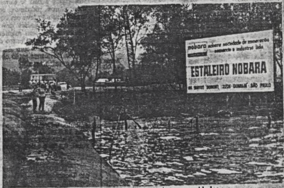
A empresa está preparando o terreno para instalar suas unidades
