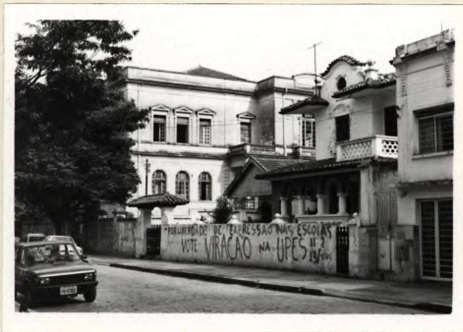
ASPECTOS DO ENTORNO IMEDIATO AO COLÉGIO 2
