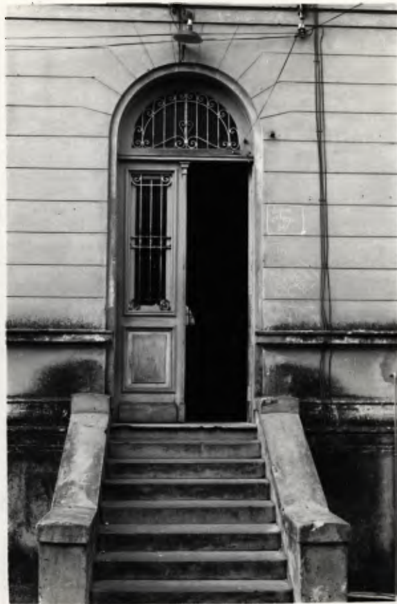
A PORTA DA FACHADA DE FUNDOS
