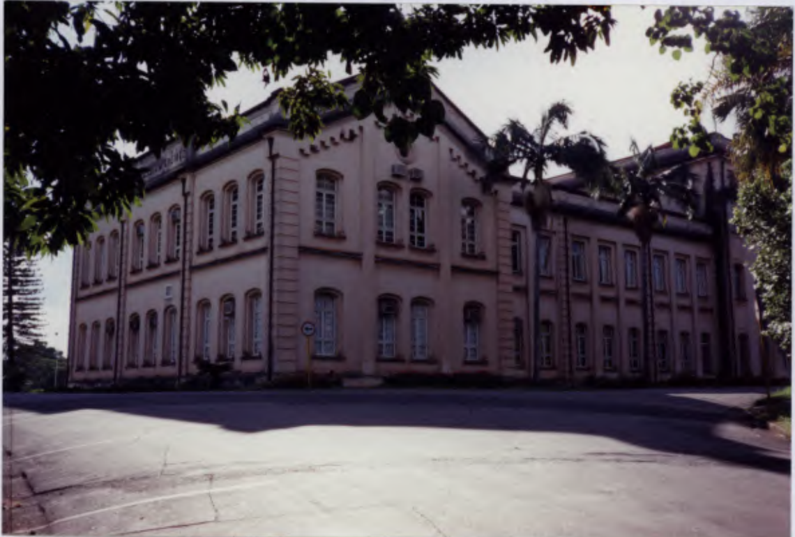
PRÉDIO PRINCIPAL - FACHADA LATERAL DIREITA E POSTERIOR
