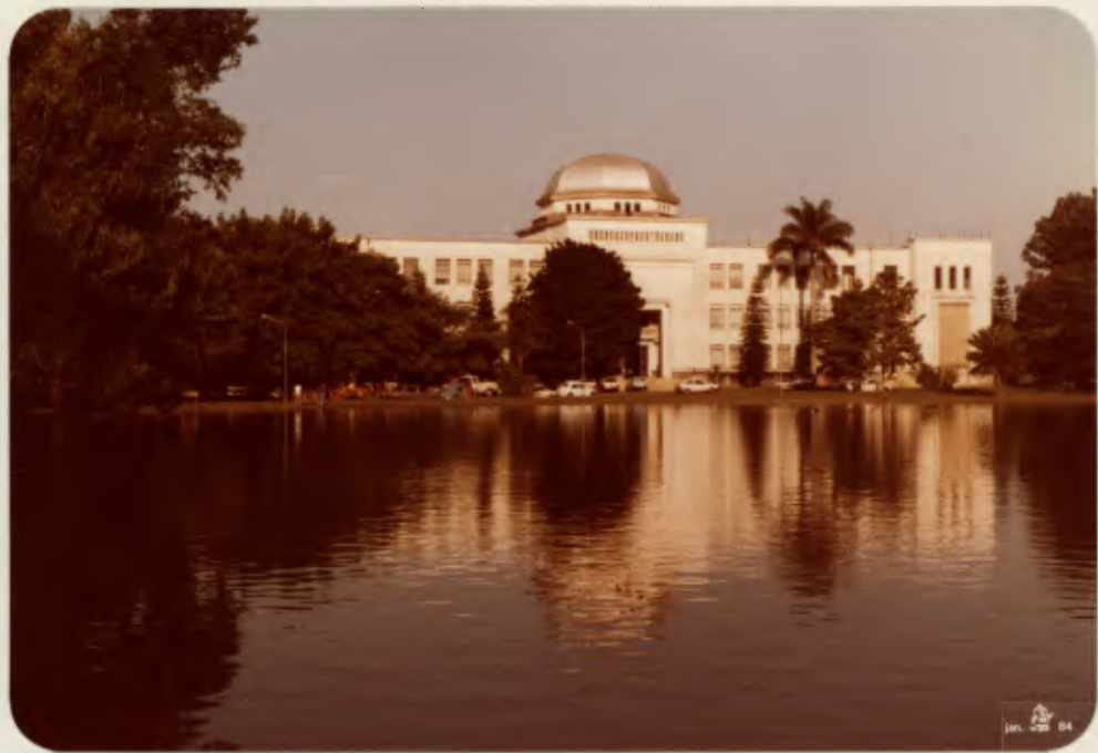
7) Prédio da Engenharia
