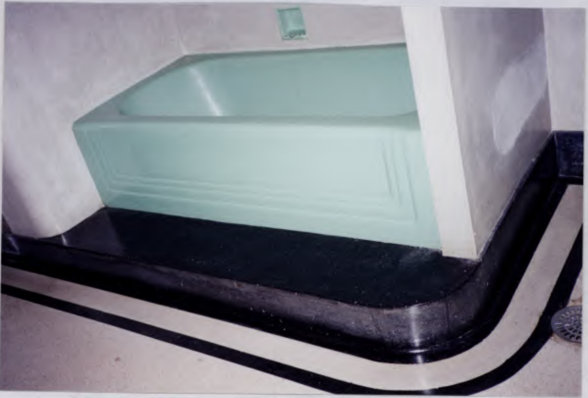
RESIDÊNCIA DIRETOR (MUSEU) - DETALHE BANHEIRO
