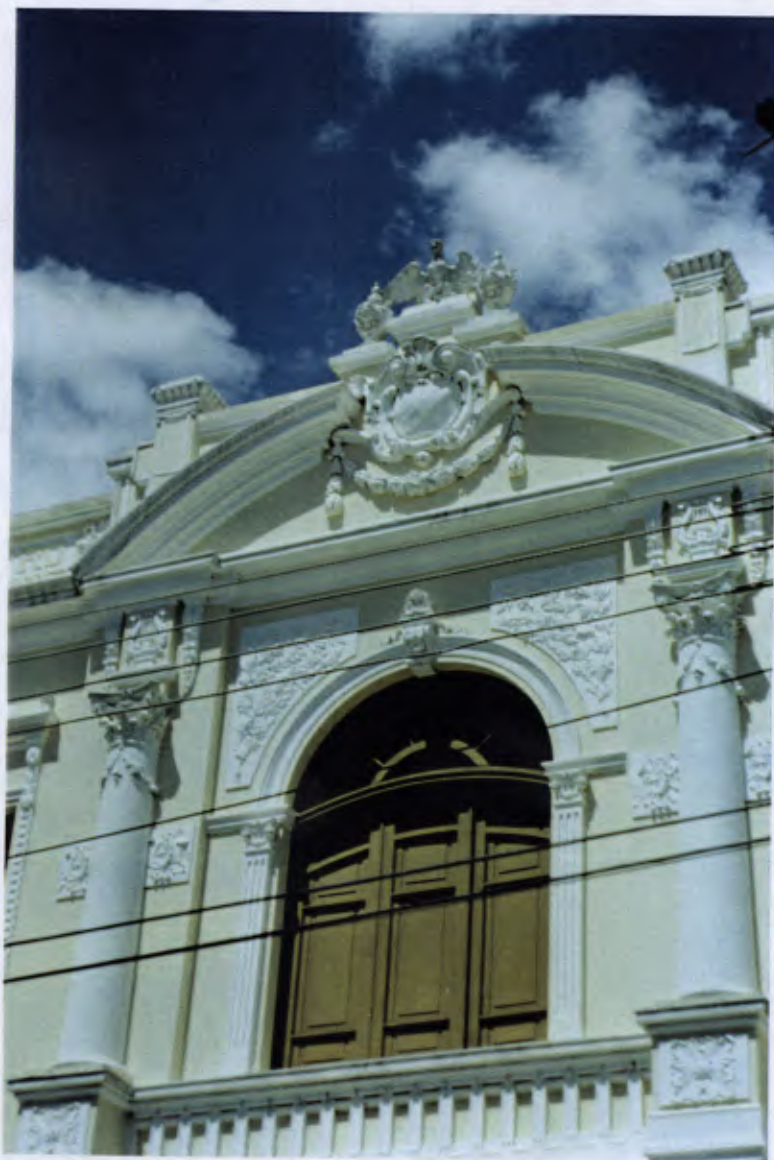
DETALHE DA FACHADA DO TEATRO MUNICIPAL RESTAURADA
