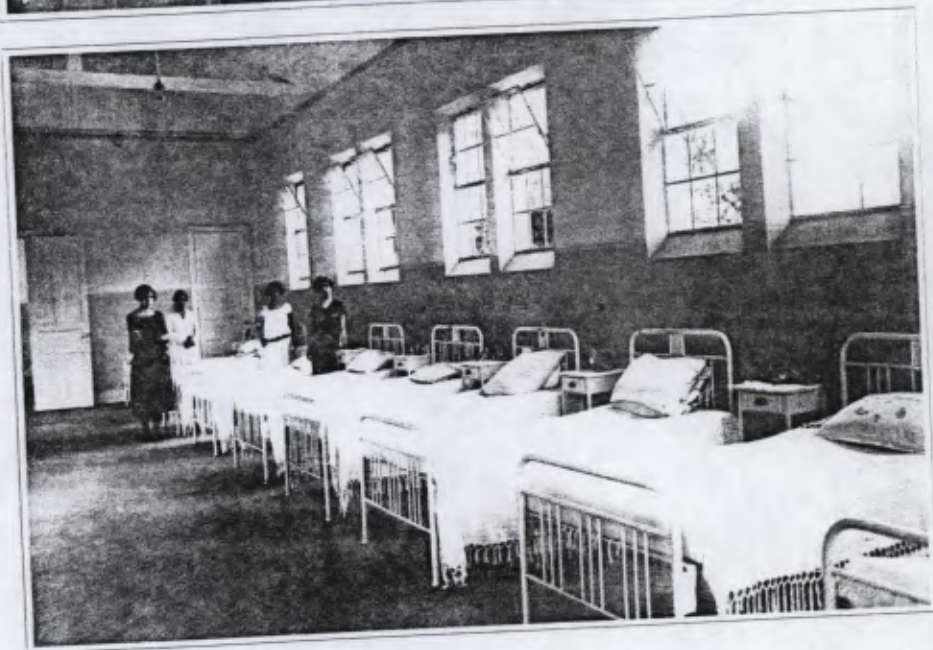
Enfermaria com janelas em parede oposta à galeria provocando ventilação cruzada
