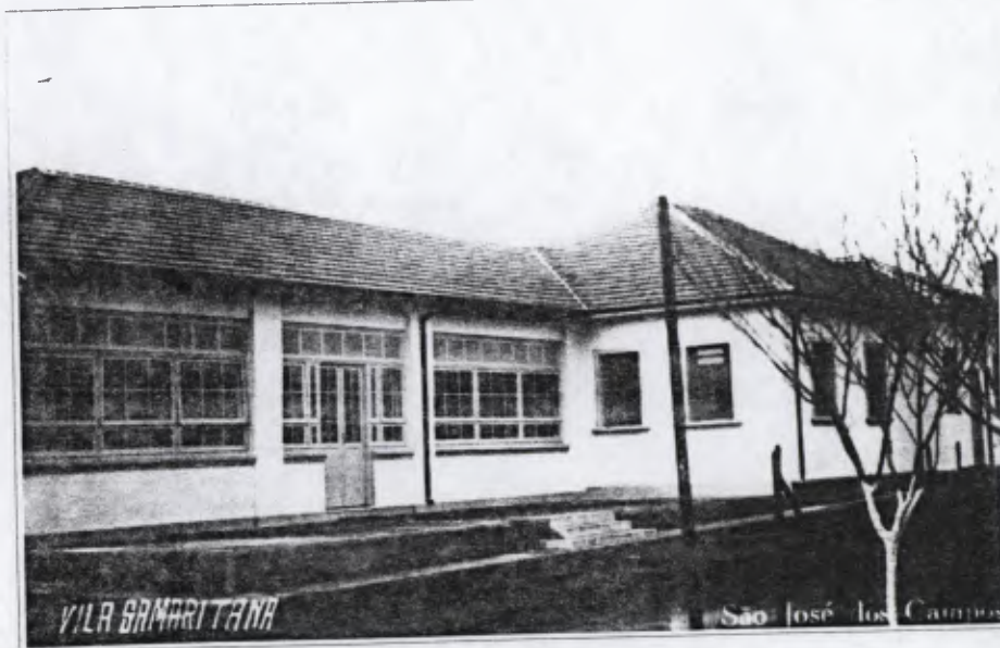
Vista do Pavilhão Dorcas onde se vê o conjunto de esquadrias, já retiradas, que vedavam a galeria de cura
