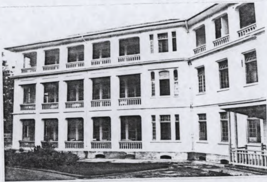
Galeria de cura no terceiro pavimento foi construída posteriormente
