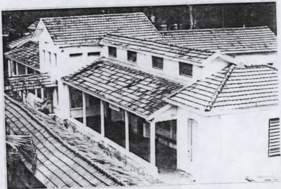
Lanterns na cobertura sobre as enfermarias
