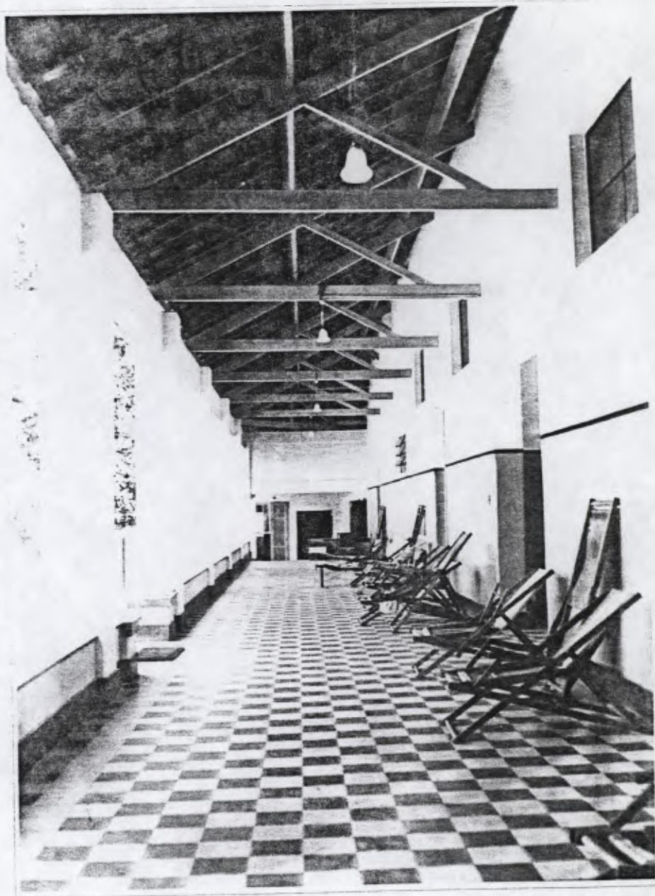
Galeria de cura na ala masculina onde se vê o piso hidráulico e barra impermeável a meia altura
