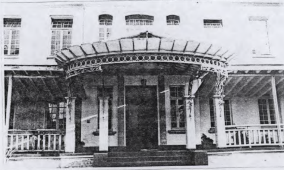
Detalhe da marquise, à entrada do Pavilhão Central, com a atual cobertura em cimento amianto (originalmente, em vidro)
