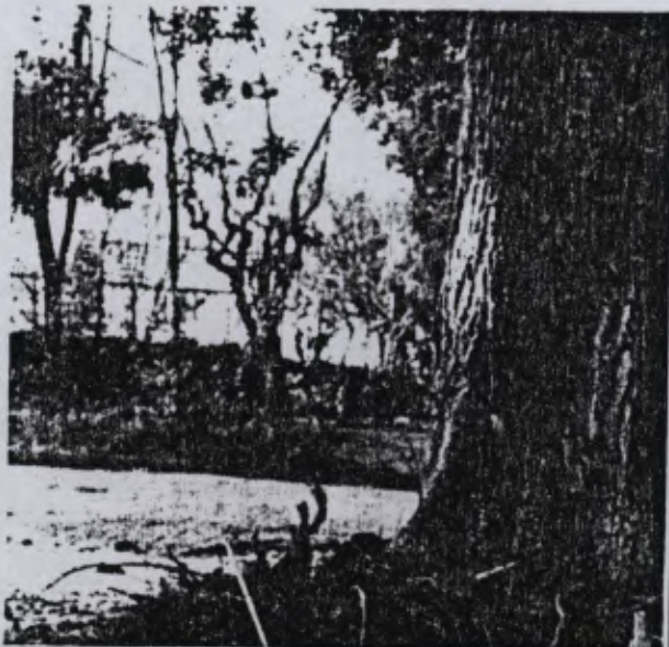
Uma das árvores atingidas pela valeta das obras sustadas.
