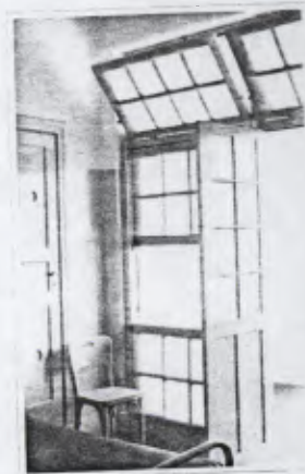
Todos os elementos que compõem as esquadrias são articuláveis - bandeira, janela guilhotina (três folhas) e porta
