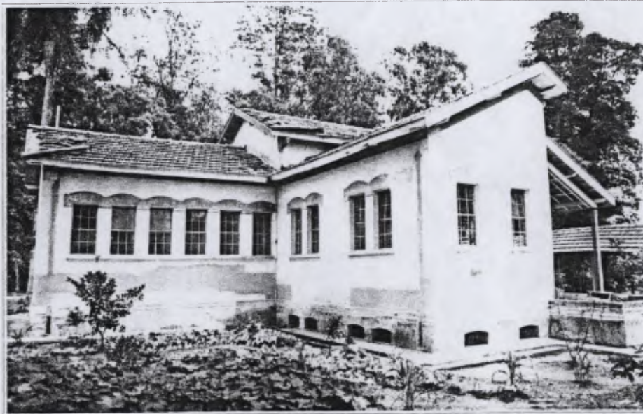
O jogo de telhado do Pavilhão Pequeno para pensionistas contribuintes – homens, dá movimento ao edifício que trás na sua fachada Norte a galeria de cura
