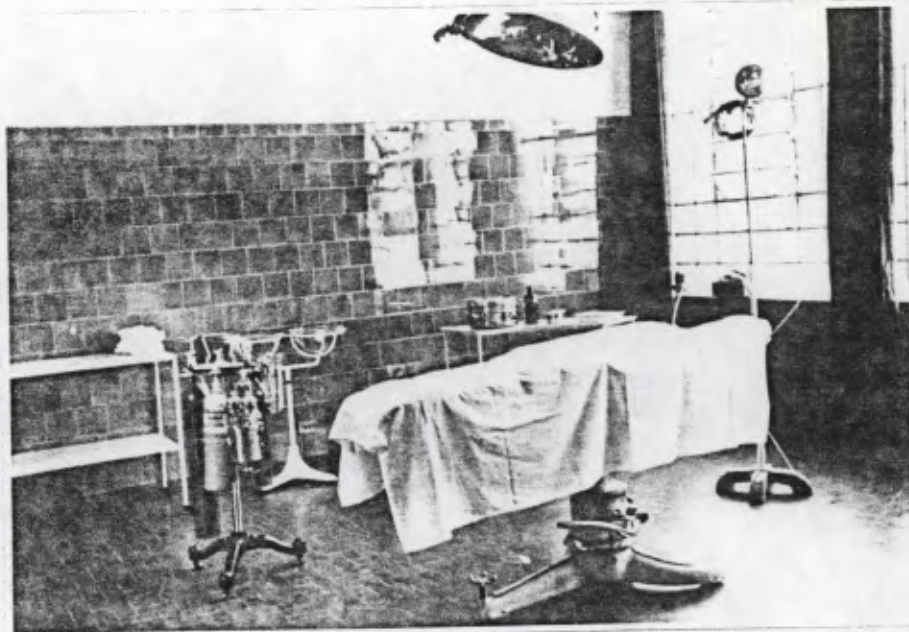
Sala de cirurgia com piso lavavel e paredes azulejadas a meia altura. As janelas são do tipo basculantes
