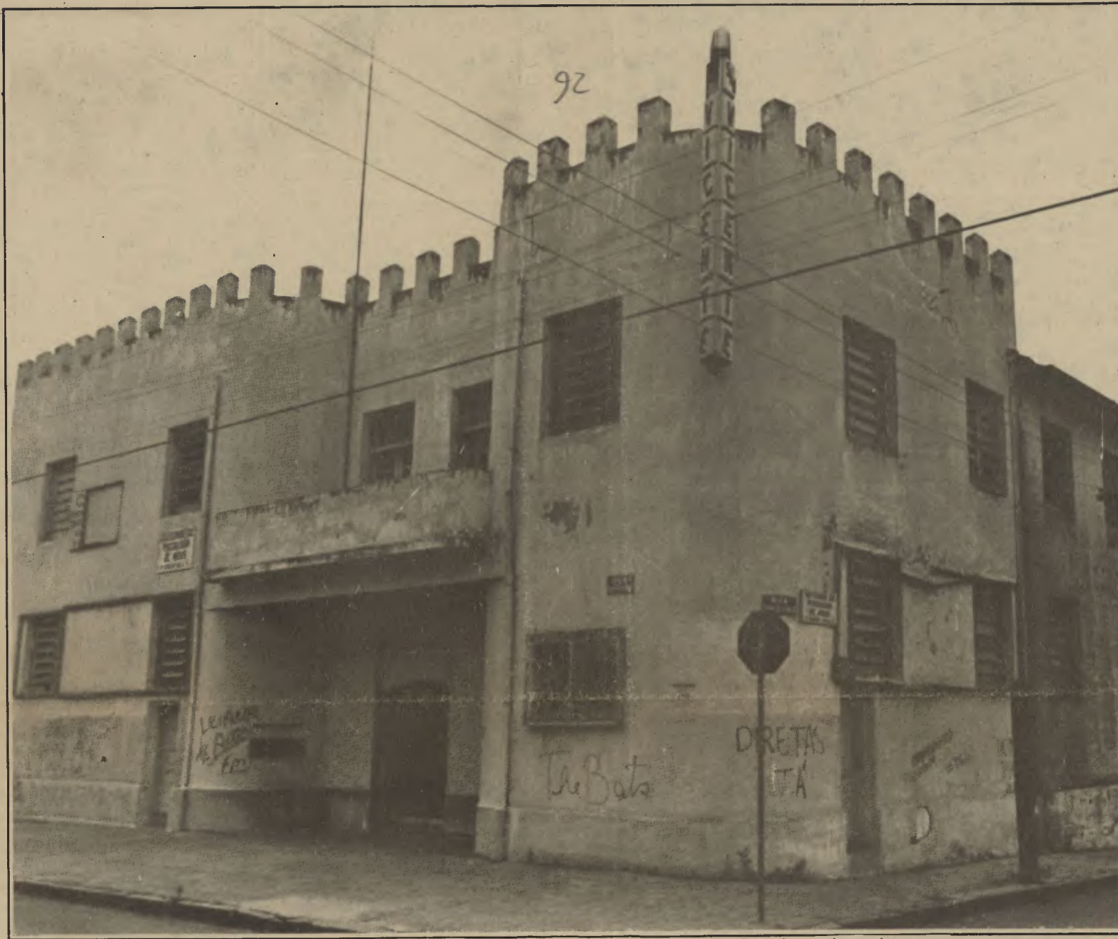
Depois que o cinema fechou, nenhuma reforma foi feita. Agora, é lutar pela restauração e preservação. Isto, depois do tombamento.
