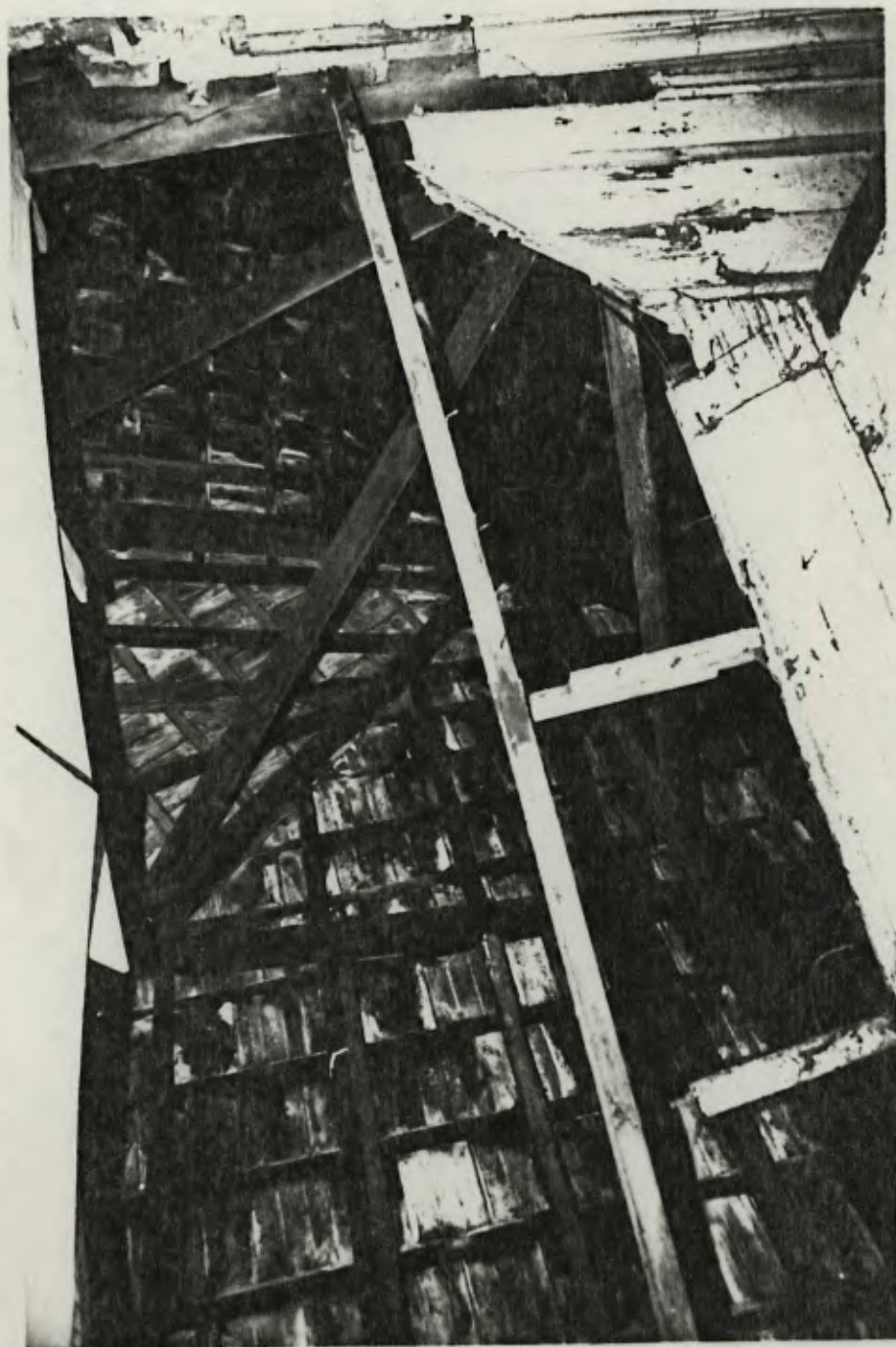
FOTO 31 - Detalhe da estrutura do telhado e do forro de madeira tipo caixão ou ar- tezoado.
