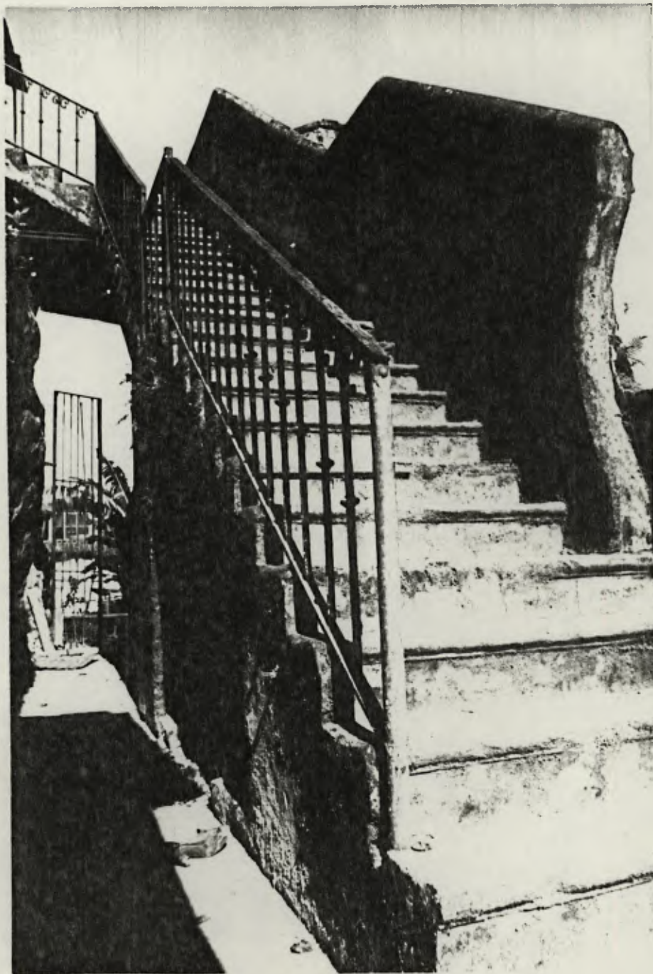
FOTO 23 - Vista inferior da escadaria de acesso à edificação.
