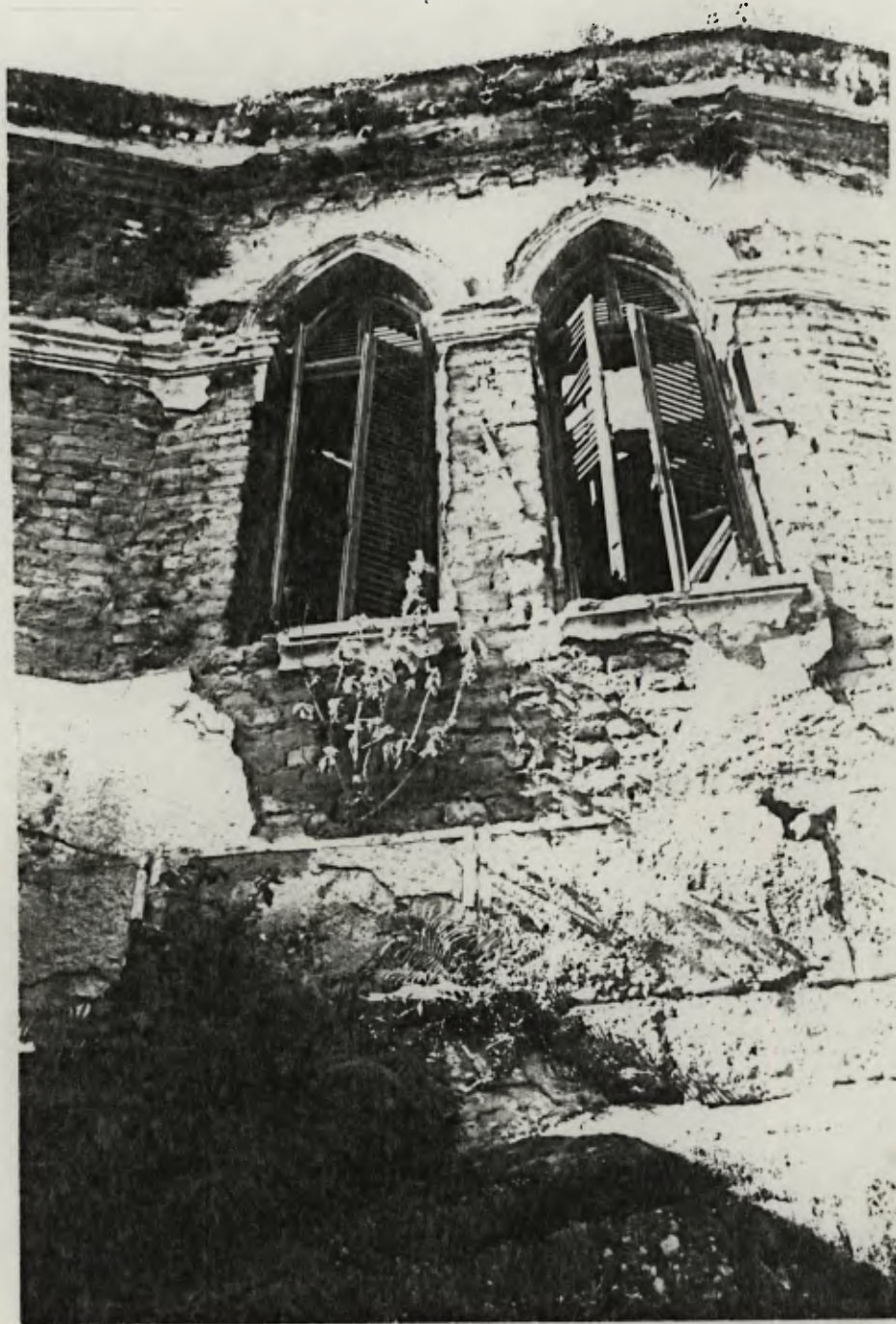
FOTO 08 - Detalhe das janelas da fachada oeste.
