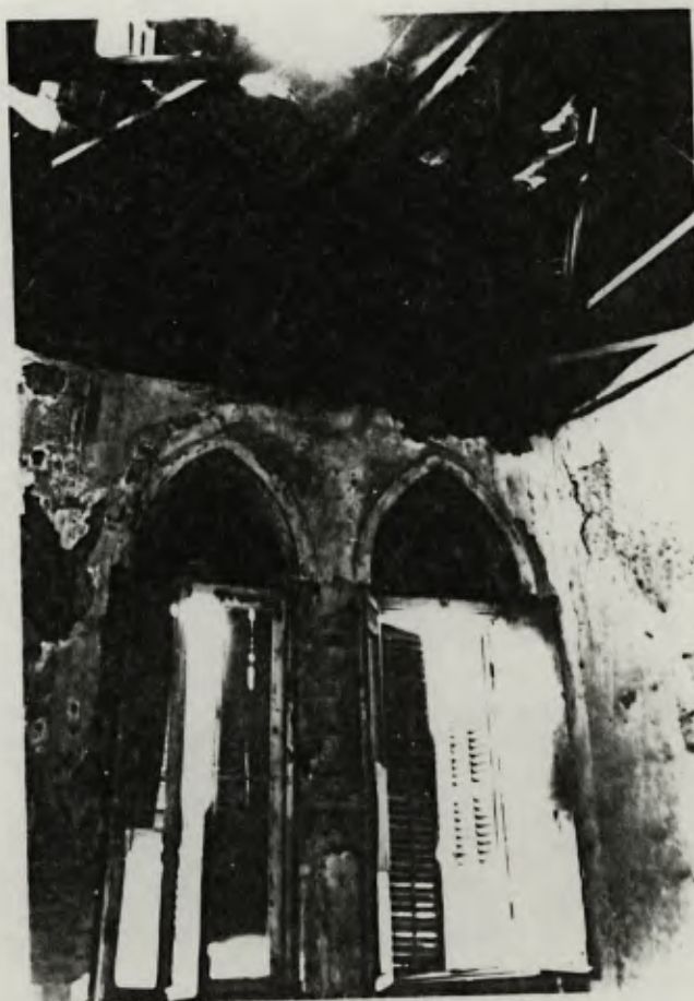
FOTO 28 - Vista interna das janelas em arco ogival da fachada oeste e detalhe da estrutura do te lhado.
