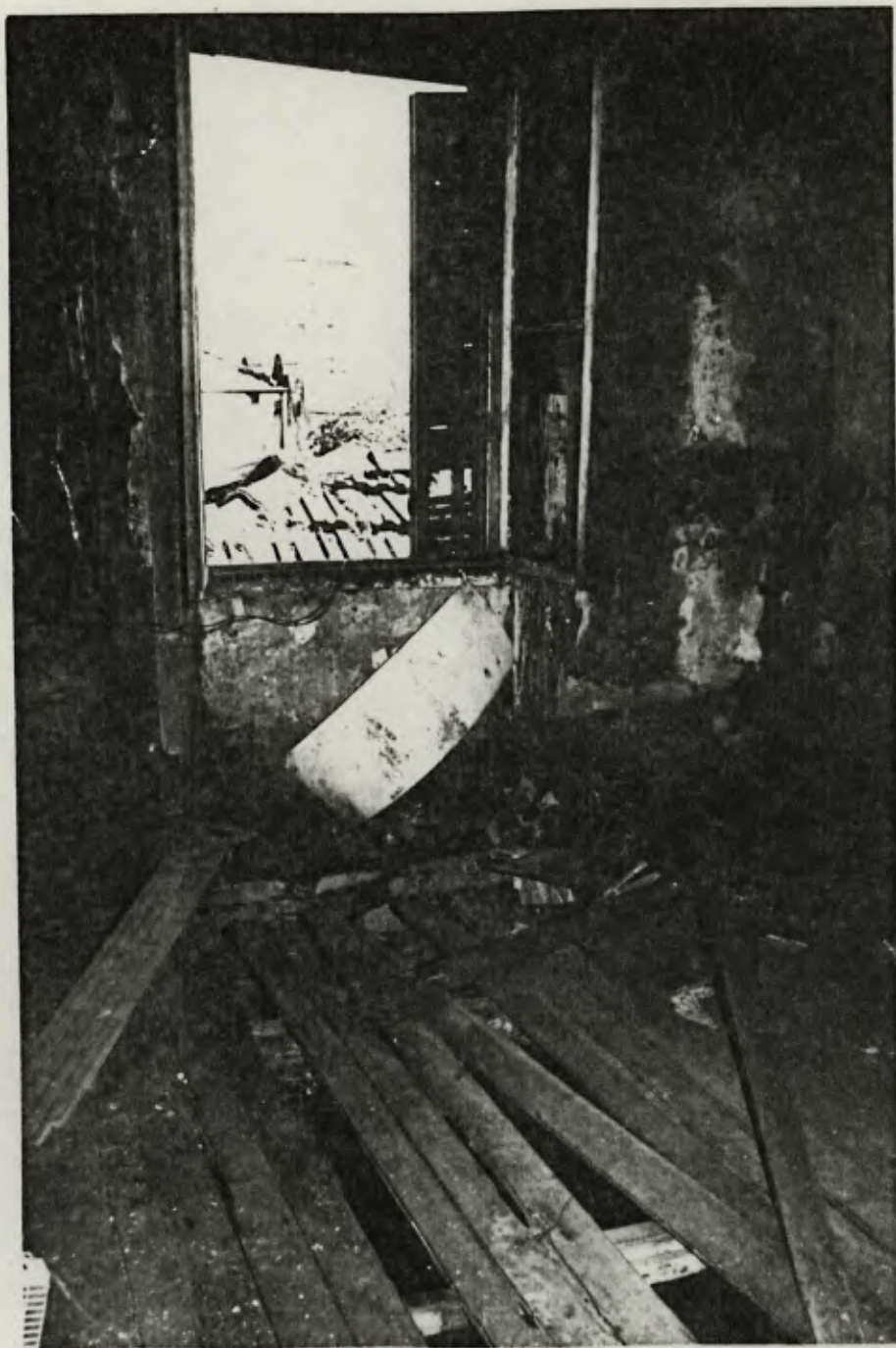
FOTO 29 - Vista interna de uma das dependências voltadas para a fachada oeste.
