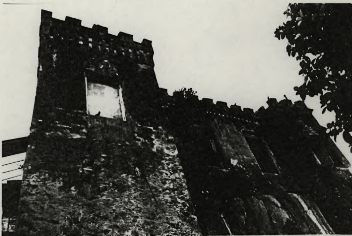
FOTO 13 - Vista da fachada sul.
