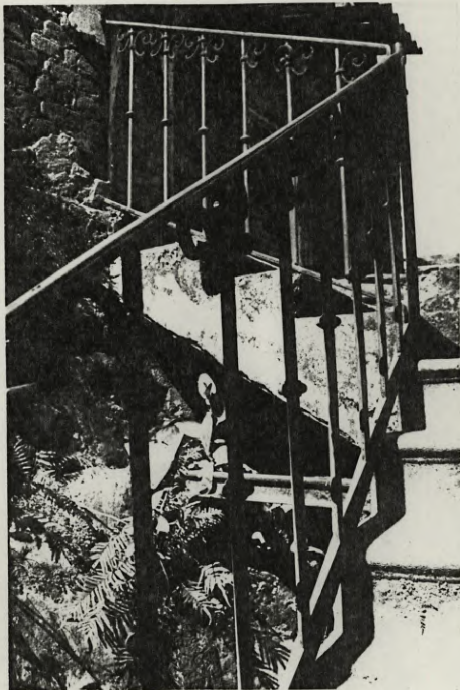
FOTO 24 - Detalhe do gradil do lance da escada chegando ao terraço da entrada principal.
