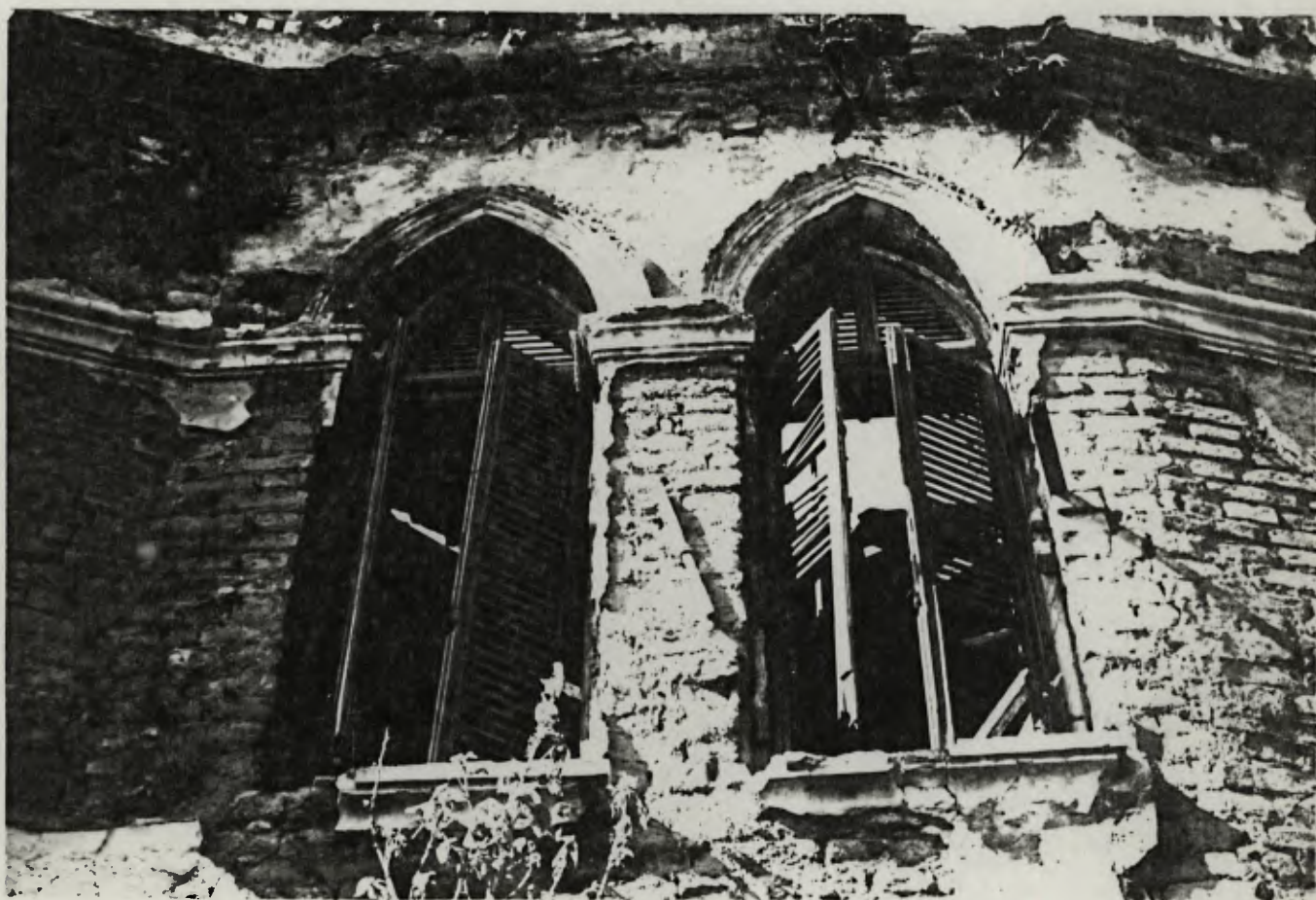
FOTO 09 - Janelas da fachada oeste com arcos ogivais.
