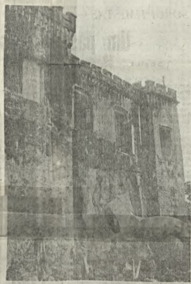
— Parte da frente do edifício (que hoje fica nos fundos), podendo-se observar em baixo da janela a esquerda, os orifícios (respiradouros) do suposto calabouço
