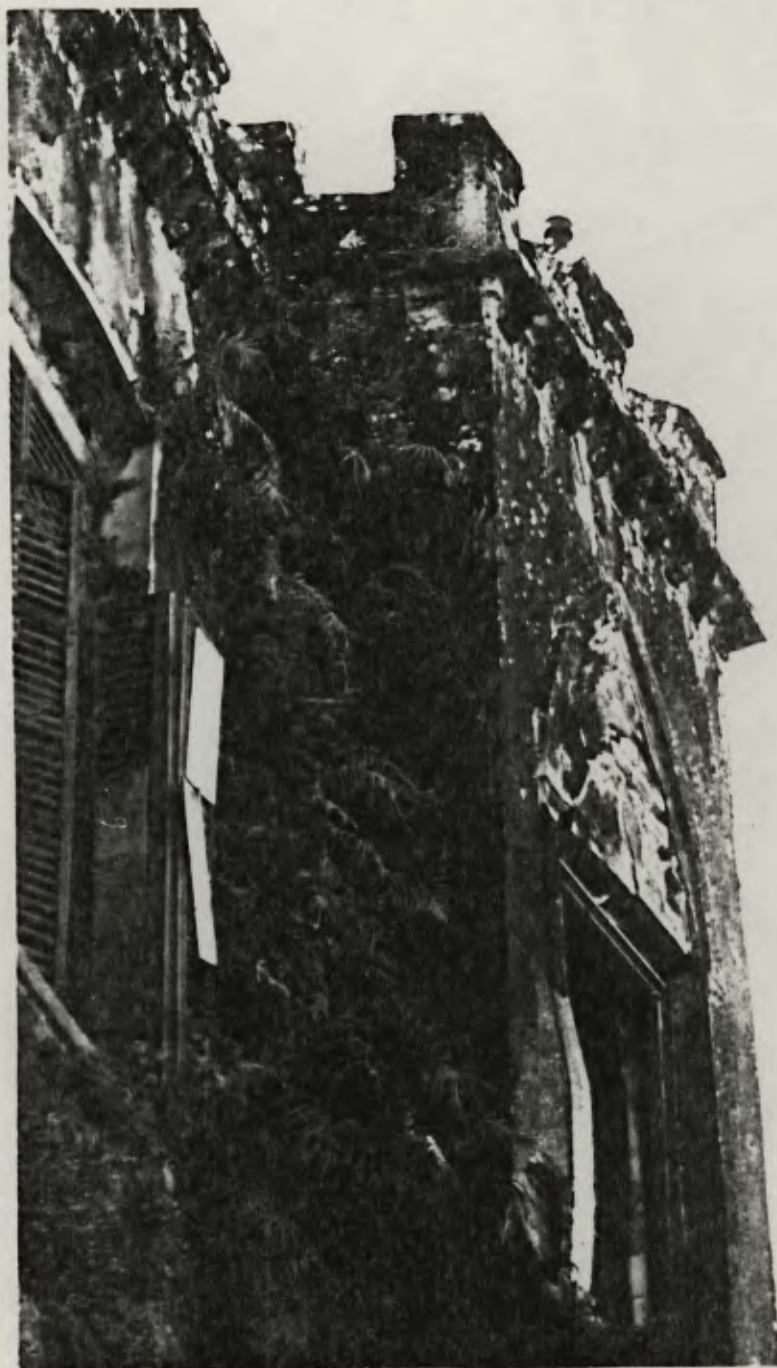
FOTO 18 - Detalhe do torreão direito da fachada sul, vendo-se as améias da platibanda.
