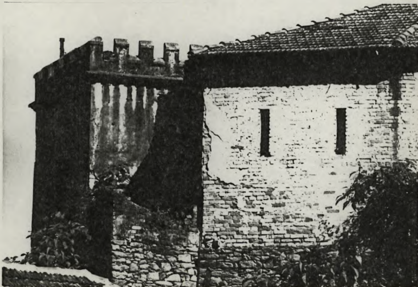
FOTO 12 - Detalhe da fachada leste. Observe-se as seteiras localizadas na cozinha, bem como as améias da platibanda.
