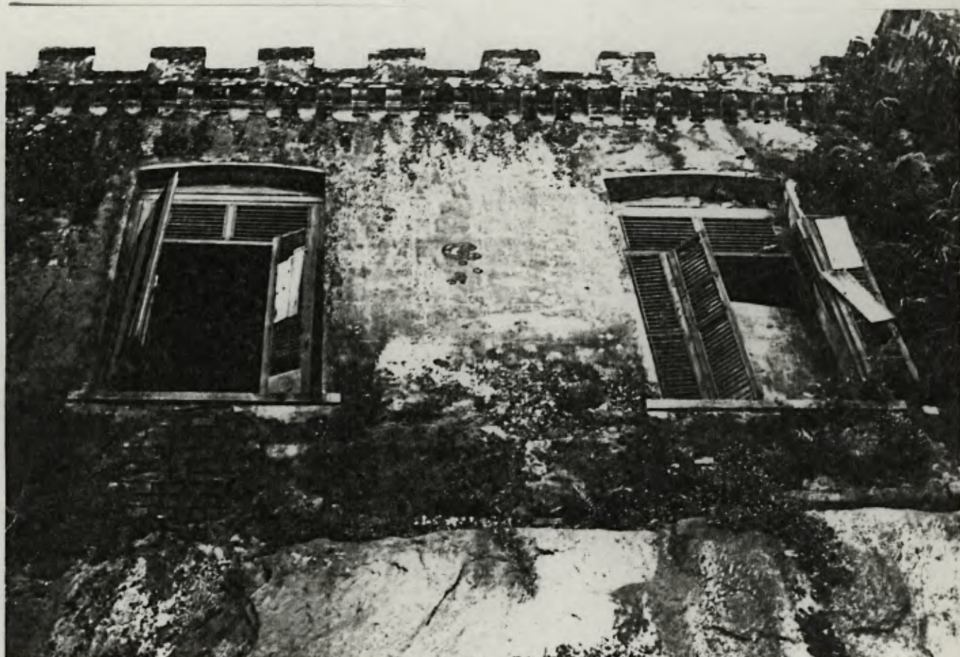
FOTO 15 - Detalhe das janelas centrais da fachada sul com arcos abatidos.
