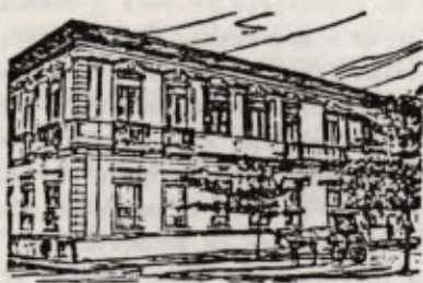
Edifício do Centro Municipal Lorena
